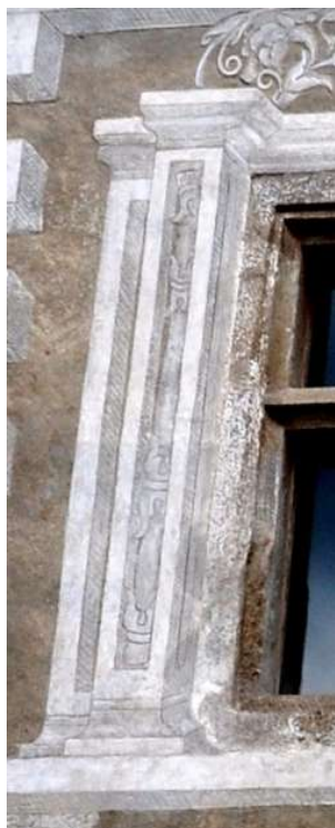
Obr. 123 Iluzivní sgrafitové pilastry, dům č. p. 518, Slavonice [Zdroj: Foto Michaela Musilová]
