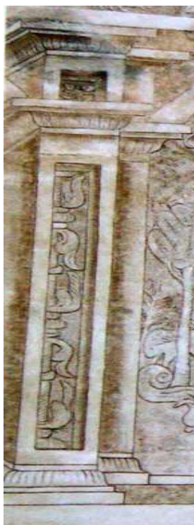
Obr. 124 Iluzivní sgrafitové pilastry Gemalten Haus, Eggenburg [Zdroj: Archiv restaurátorských zpráv, RZ 3040 AB, Václav Špale, Restaurování fasády domu čp. 518, 2004 ]
