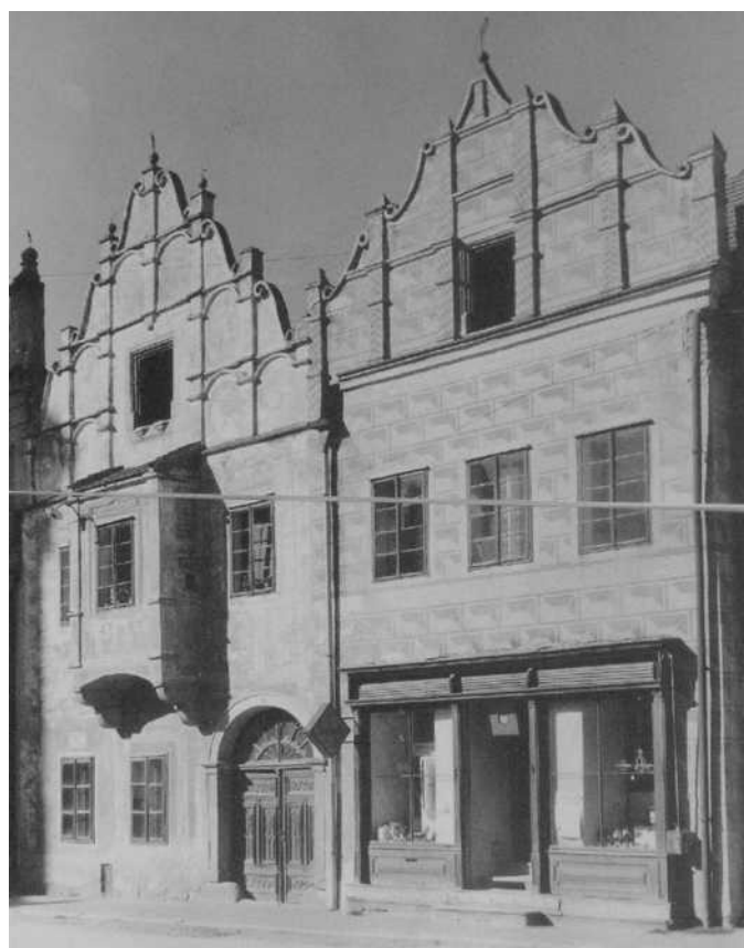
Obr. 27 Dům č.p. 518 (86), fotografie z roku 1950 [Zdroj: Archiv restaurátorských zpráv, RZ 3040 AB, Václav Špale, Restaurování fasády domu čp. 518 , 2004]
