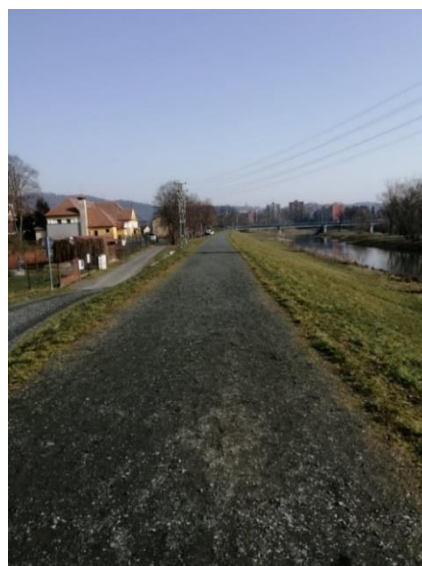
Obrázek 10: Protipovodňová hráz (foto: vlastní, únor 2021)
