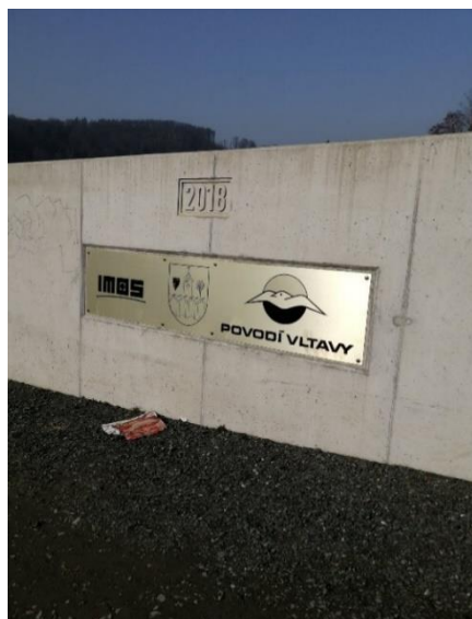
Obrázek 9: Protipovodňová zeď (foto: vlastní, únor 2021)
