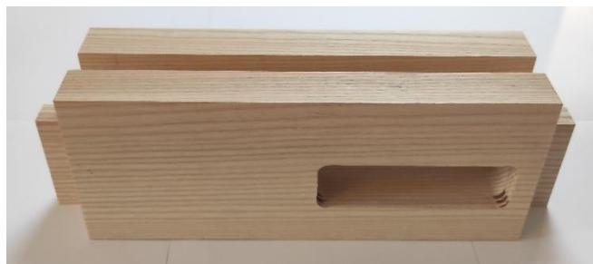
Obrázek 3.VII – Otvory spodního obložení
