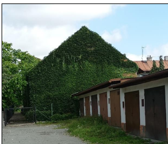
Obr. 11: příklad stěny z kategorie "celá stěna" (zdroj: vlastní fotografie, pořízeno 29.8.2022)
