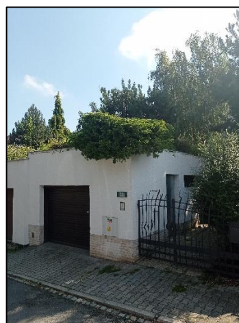
Obr. 24: příklad intenzivní zelené střechy (zdroj: vlastní fotografie, pořízeno 12.8.2022)
