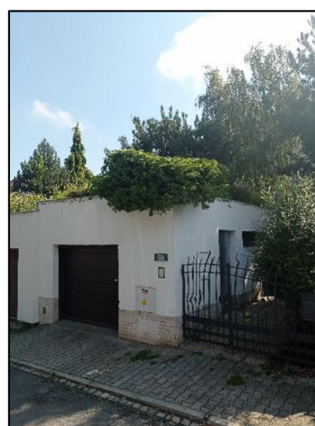
Obr. 24: příklad intenzivní zelené střechy (zdroj: vlastní fotografie, pořizeno 12.8.2022)
