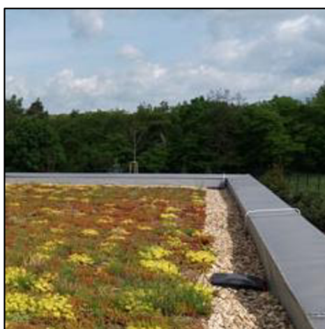
Obr. 23: extenzivní zelená střecha na víceúčelové hale (zdroj: Dobrovolná, 2019)
