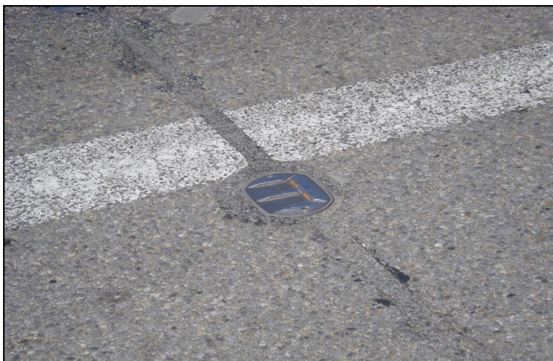
Detail světelného dopravního knoflíku u přechodu pro chodce.
