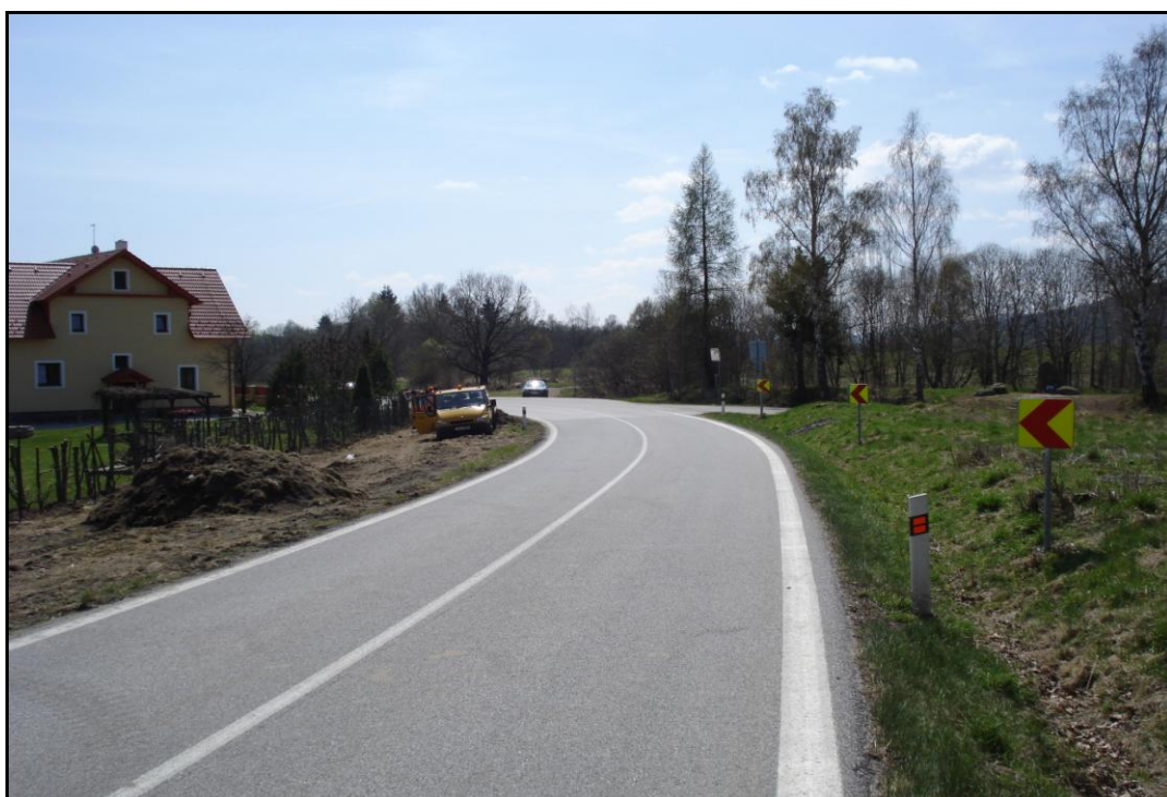
Bližší pohled na „křižovatku“ ve směru jízdy od Prachatic.
