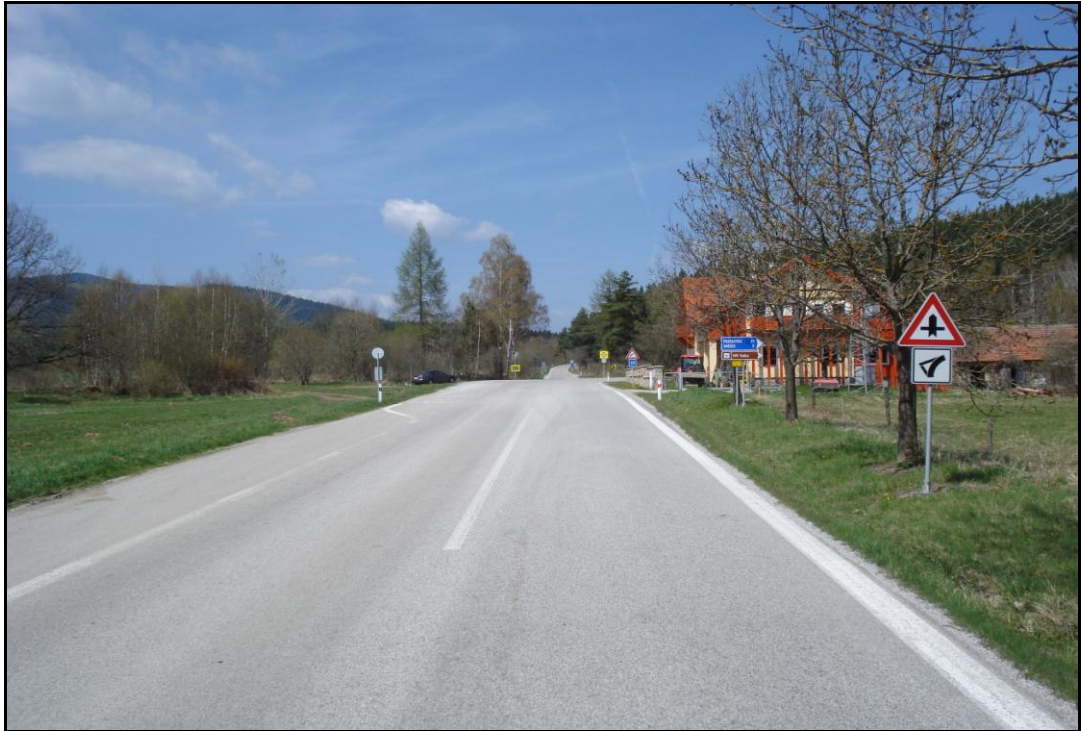
Celkový pohled na „křižovatku“ ve směru jízdy od Chvalšín.
