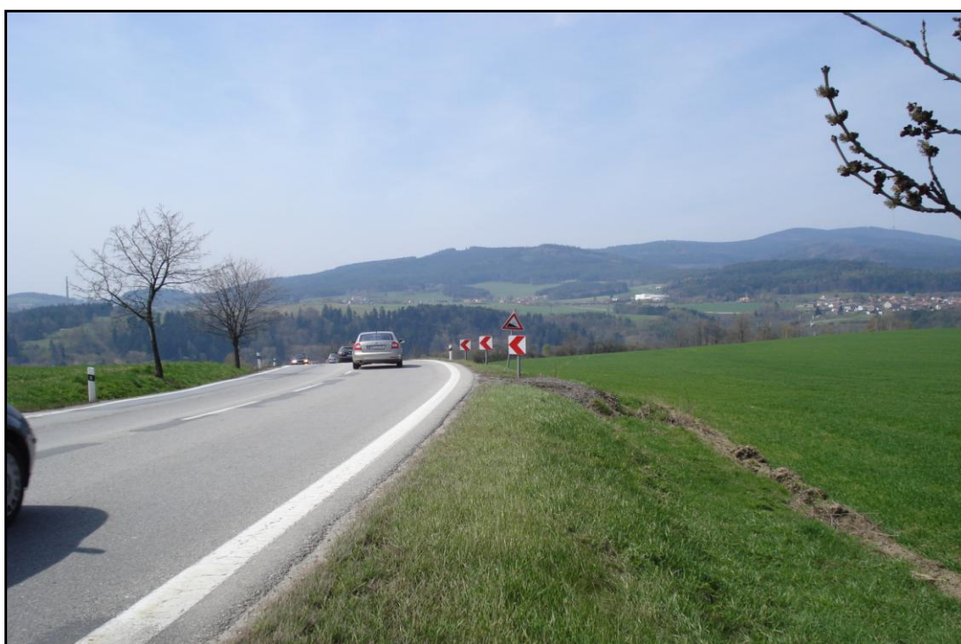
Celkový pohled na odstraněné vzrostlé stromy v levotočivé zatáčce na počátku klesání před obcí Rájov, na sil. č. I/39.
