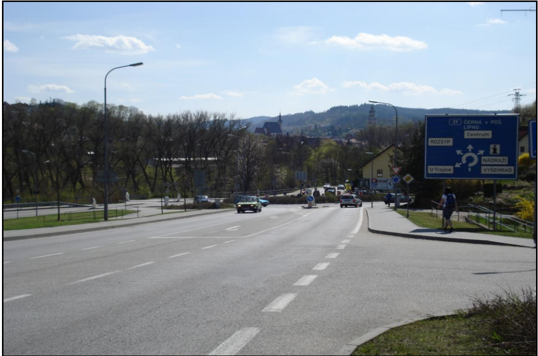
Celkový pohled na okružní křižovatku ve směru jízdy od Č. Budějovic.
