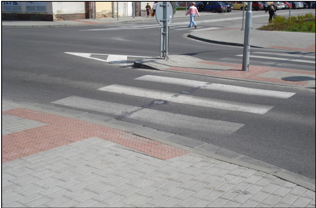
Detail světelných dopravních knoflíků a speciálního povrchu pro osoby se zrakovým postižením.
