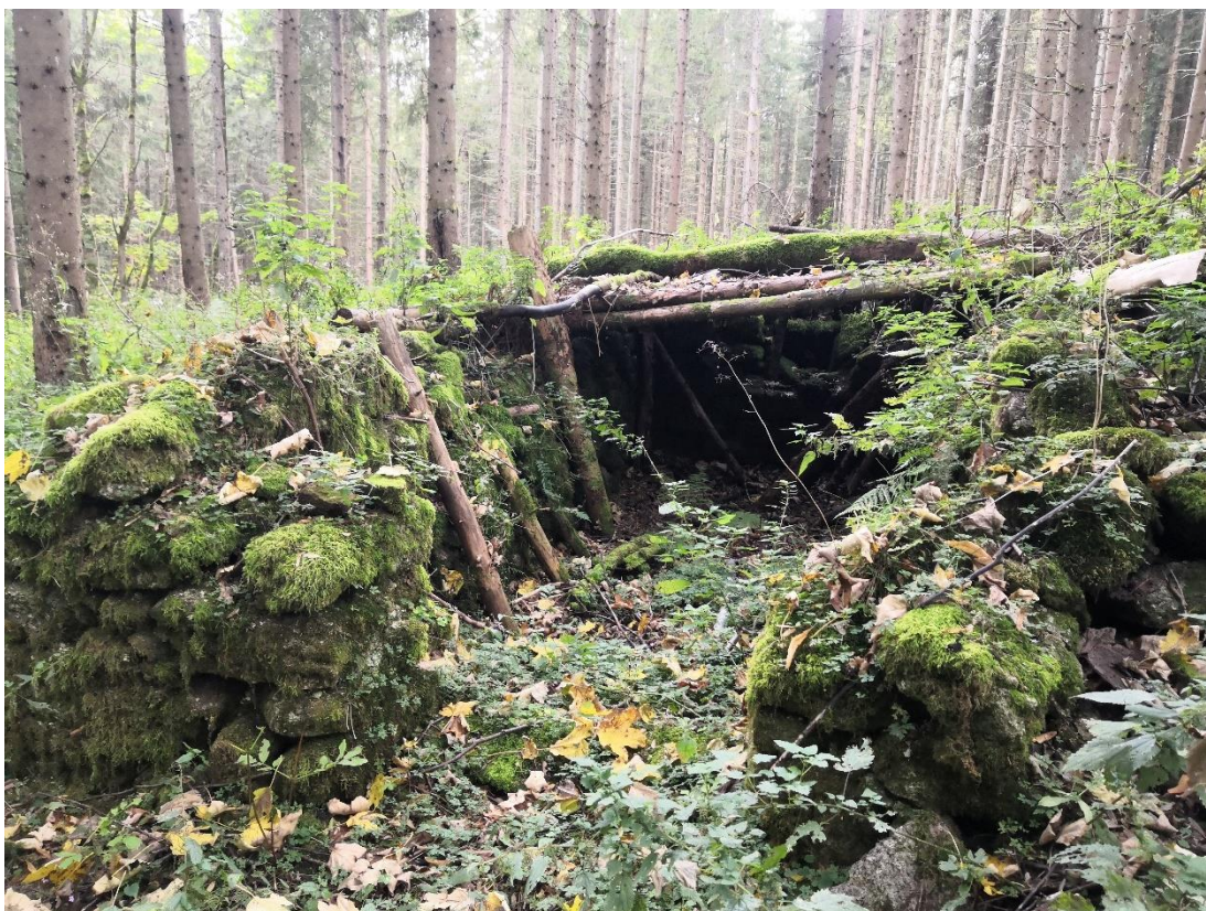
Příloha 20: Ruina jedné z bývalých usedlostí osady Pavlína
