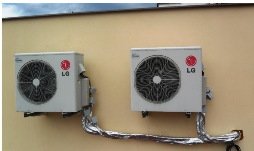
Obr. 16: Vonkajšia klimatizačná jednotka LG [28].
