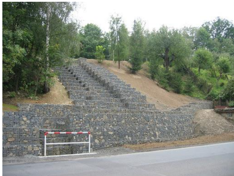
Obrázek 17: Opěrná gabionová zeď (algon-eshop.cz)
