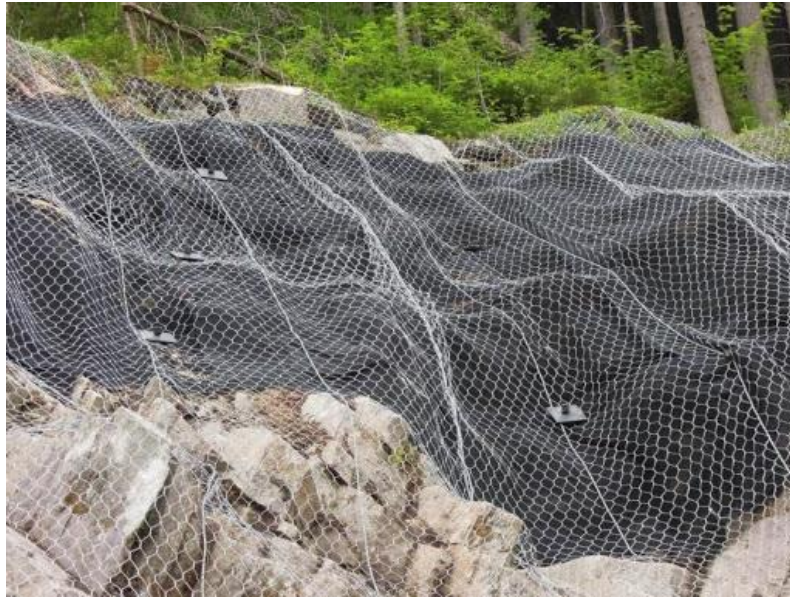
Obrázek 18: Stabilizace skalnatého svahu ocelovou sítí (peterajiri.cz)
