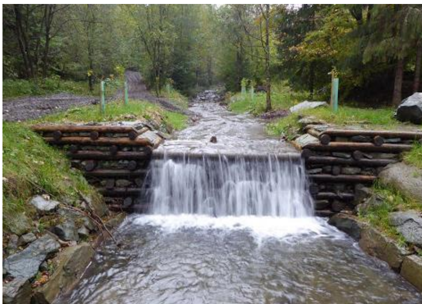
Obrázek 14: Dřevěná přehrážka vyztužená kamenem (silvarium.cz)
