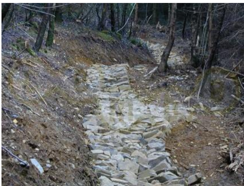
Obrázek 27: Nová trasa zpevněna kameny (cemba.eu)
