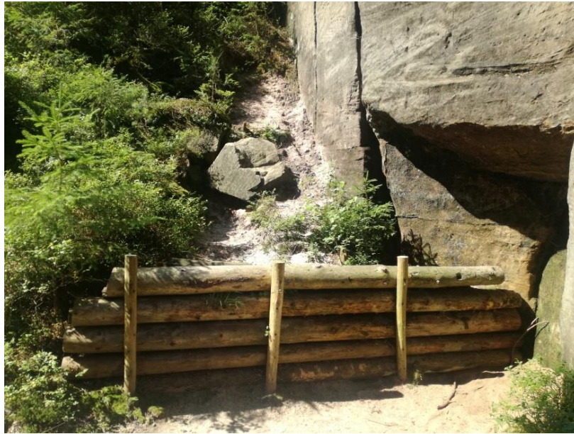
Obrázek 16: Stabilizační opevnění strmých svahů z kulatiny ve skalním masivu
