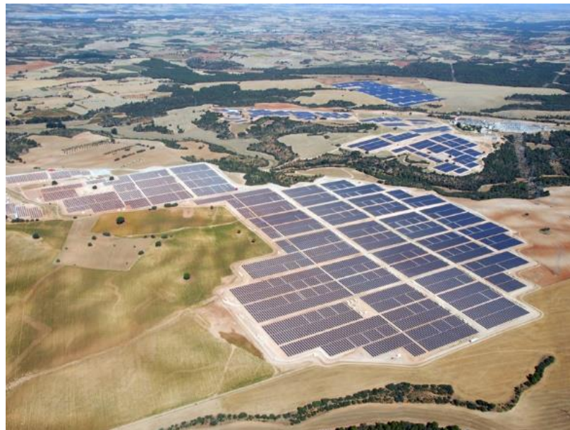
Obr. 4-5 Fotovoltaický park ve Španělsku [19]
