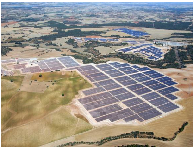
Obr. 4-5 Fotovoltaický park ve Španělsku [19]
