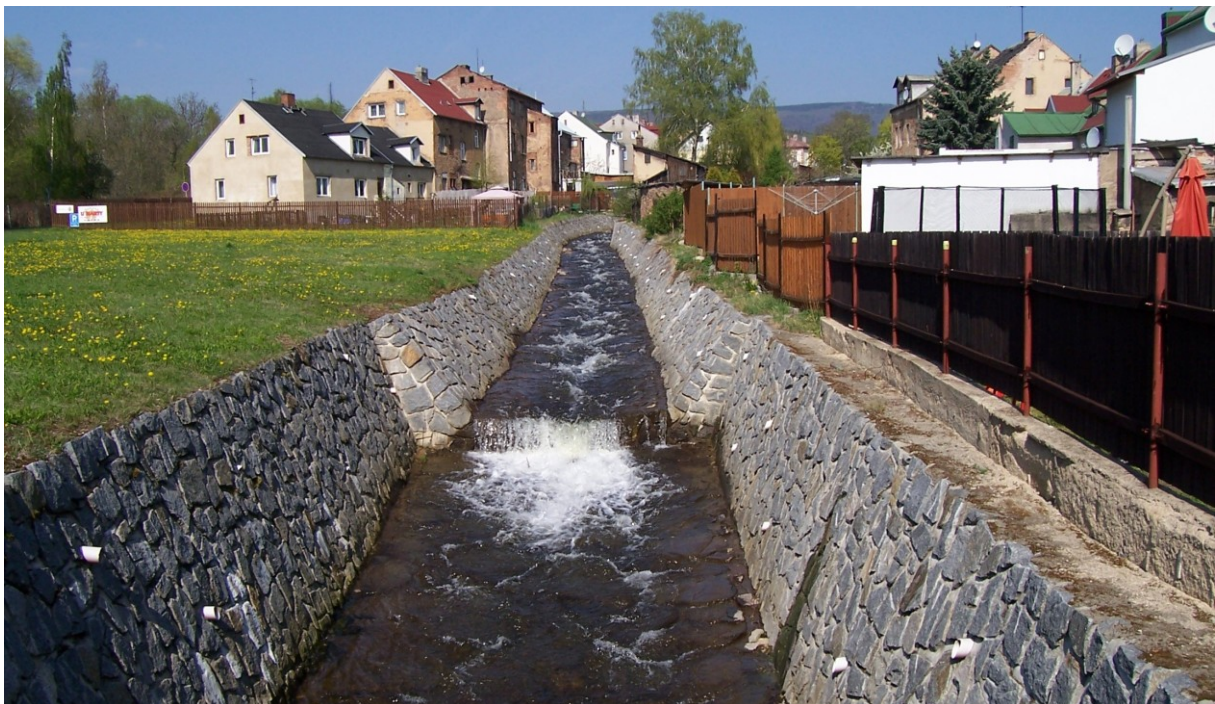
foto č. 2 – upravené koryto Bystřice při průtoku obcemi Mikroregionu, foto autor
