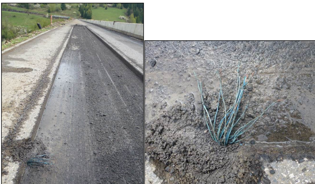
Obr. 7.13 Zničená sonda VL_1
