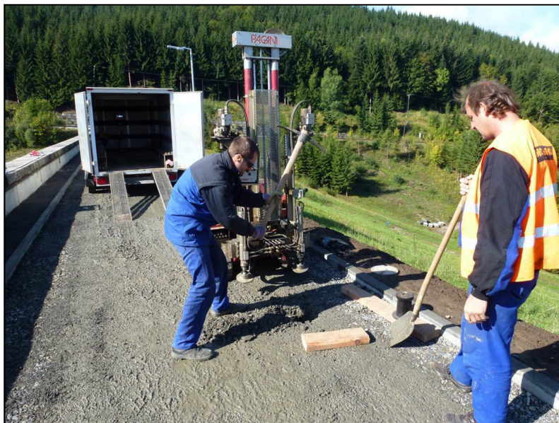
Obr. 7.14 Instalace nové sondy VL_1
