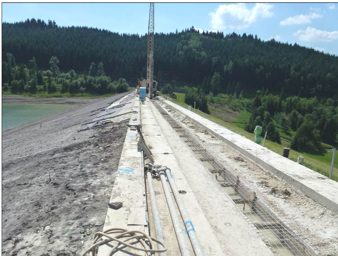
Obr. 7.12 Provádění těsnicí clony pomocí tryskové injektáže (20.6.2013)
