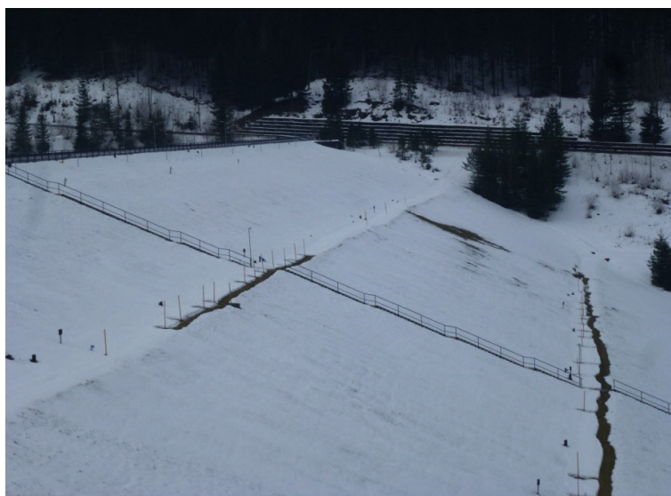
Obr. 9.2 Průsaky únor 2015
