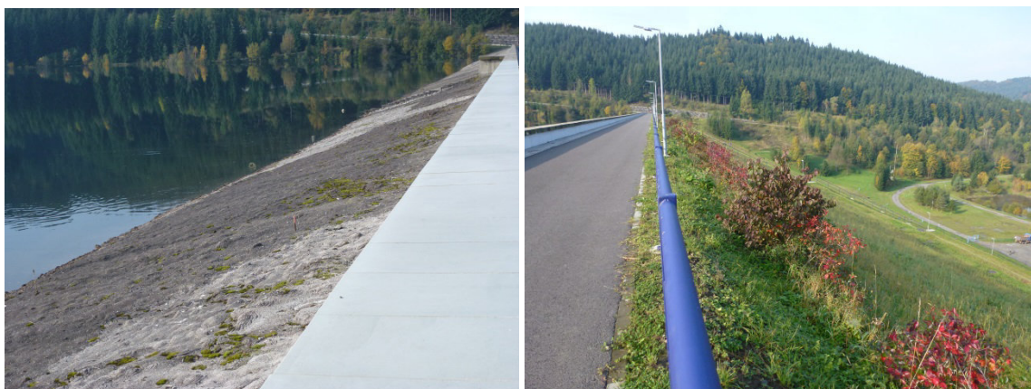
Obr.7.1 Návodní a vzdušný svah zeminí hráze VD Karolinka
