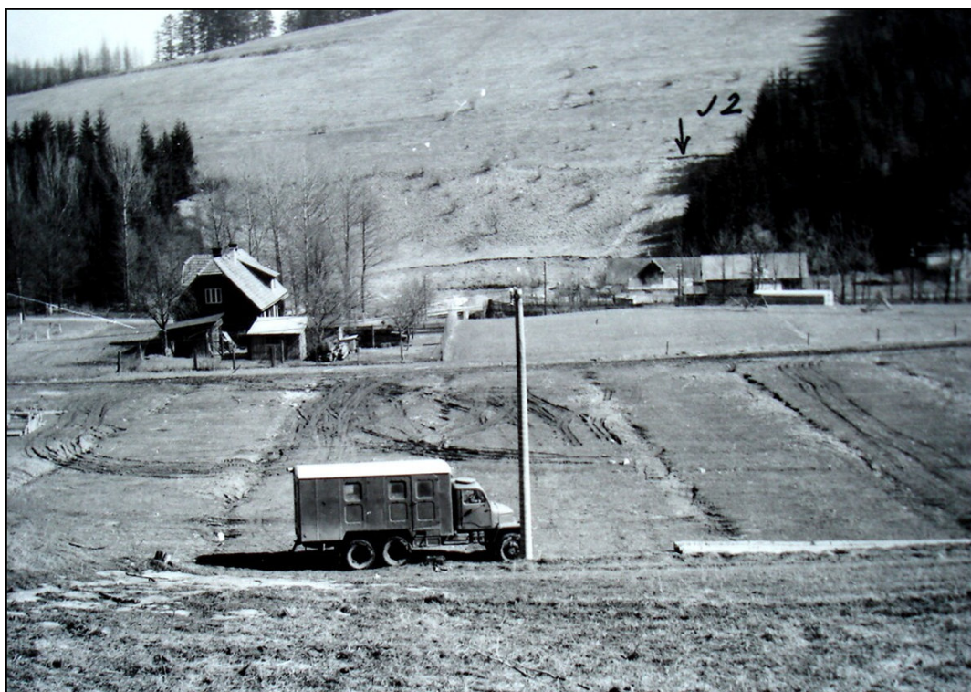
Obr. 7.3 Pohled k přehradnímu profilu z levé strany údolí
