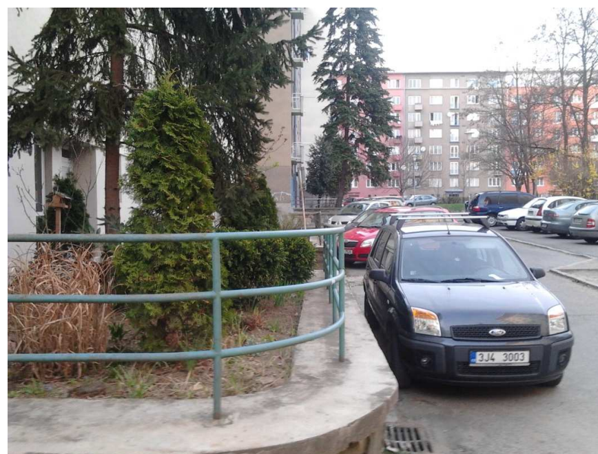
Obr. 25 Pohled na přerostlou zeď u fasád domů
