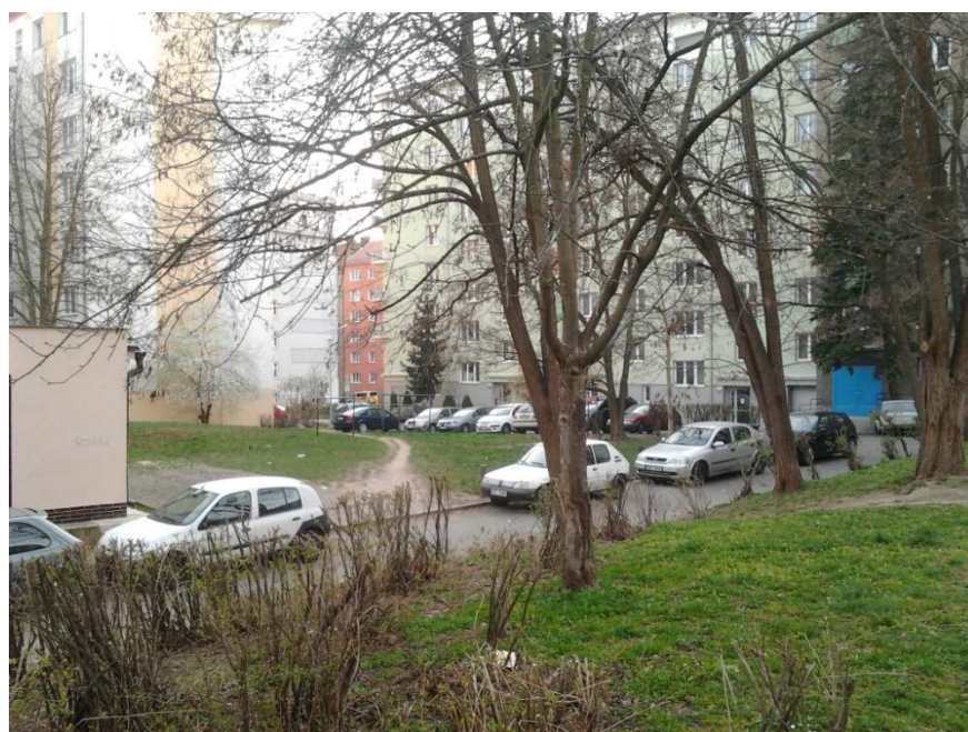
Obr. 24 Pohled do jihozápadní části vnitrobloku, v pravé části snímku nálety dřevin
