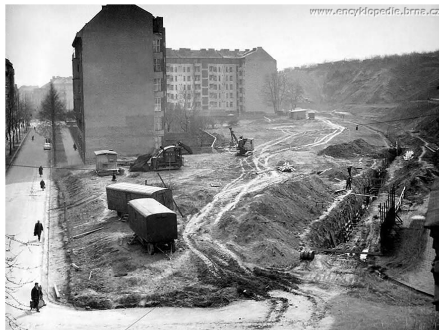
Obr. 12 Příprava na stavbu nových obytných domů na území zrušené cihelny (viz. obr. 8), pohled do nynějšího vnitrobloku směrem k ulici Grohova, vlevo na snímku ulice Čápkov, duben 1958 (Encyklopedie Brna, 2012)
