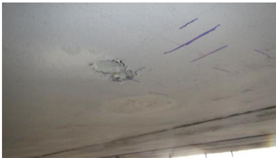
Obrázek 181: Pohled na místo provedení sondy K1.5
