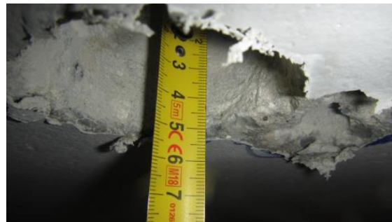
Obrázek 182: Detailní foto měření krycí vrstvy chráničky v místě sondy K1.5
