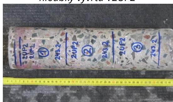
Obrázek 98: Laboratorní foto odebraného vzorku betonu z vývrtu V2ÚP2
