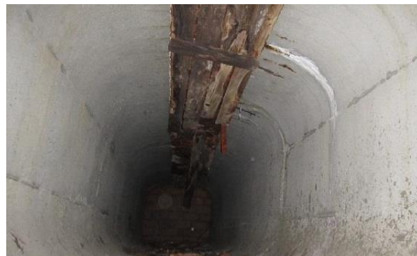
Obrázek 146: Pohled do dutiny místem odběru vývrtu VS2.9-2.10
