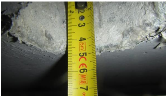
Obrázek 184: Detailní foto měření krycí vrstvy chráničky v místě sondy K1.7
