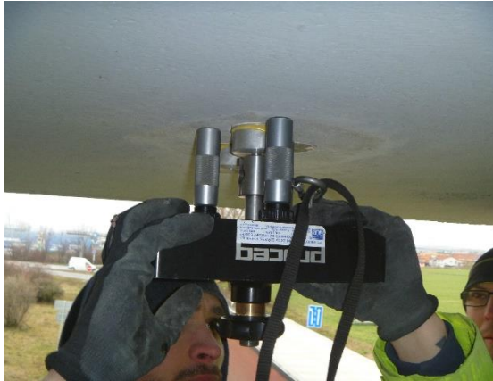
Obrázek 56: Provádění odtrhové zkoušky
