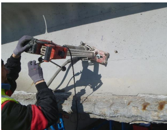
Obrázek 33: Pohled na odebrání jádrového vývrtu
