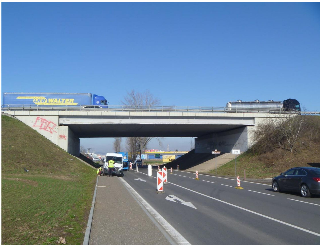
Obrázek 40: Celkový pohled na most D1-243 zprava
