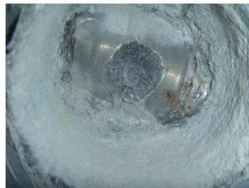
Obrázek 13: Pohled na ocelovou chráničku bez koroze
