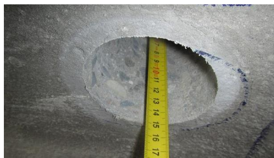
Obrázek 119: Detailní foto měření hloubky vývrtu V1N1.1
