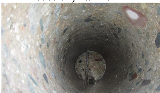
Obrázek 73: Detailní foto ostění vývrtu V2ÚP1
