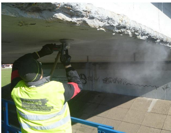
Obrázek 53: Příprava zkušebního místa pro provedení zkoušky
