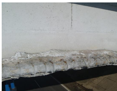
Obrázek 25: Pohled na chybějící hranu dolní příruby
