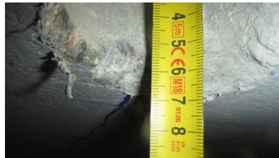
Obrázek 170: Detailní foto měření krycí vrstvy chráničky v místě sondy K2.9
