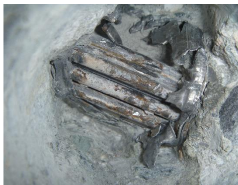
Obrázek 17: Pohled na předpínací dráty bez koroze
