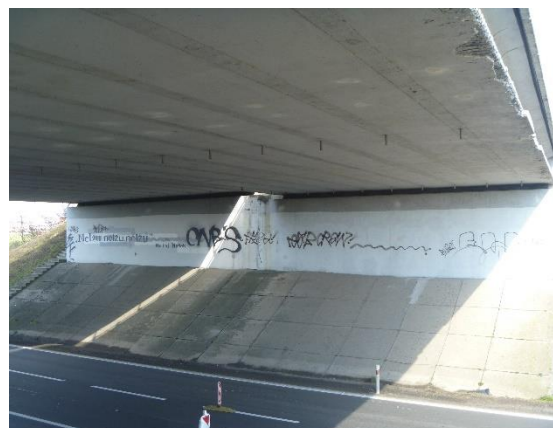
Obrázek 46: Pohled na část nosné konstrukce dálničního mostu D1-243
