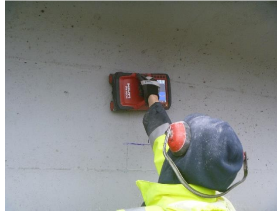
Obrázek 31: Lokalizování předpínacích kabelů pomocí přístroje Hilti PS 1000
