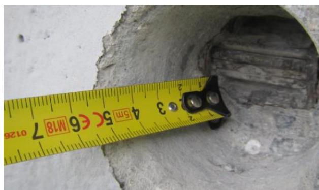
Obrázek 190: Detailní foto měření krycí vrstvy chráničky v místě sondy K1.9
