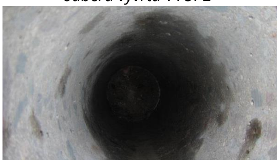
Obrázek 93: Detailní foto ostění vývrtu V1ÚP2
