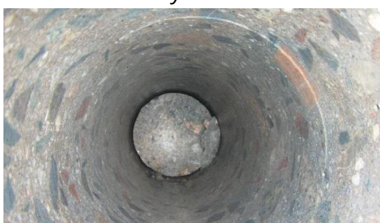
Obrázek 97: Detailní foto ostění vývrtu V2ÚP2
