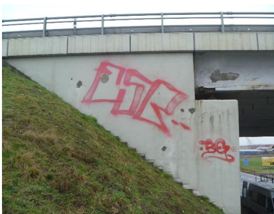
Obrázek 42: Pohled na pravé křídlo Brněnské opěry
