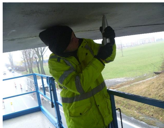
Obrázek 54: Provádění zkoušky Schmidtovým tvrdoměrem typu N
