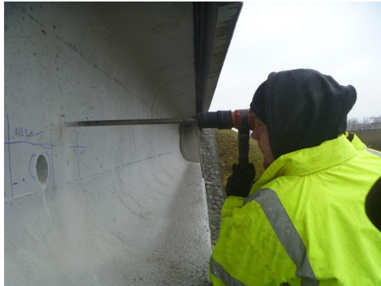
Obrázek 55: Provádění sondy k podélnému předpětí
