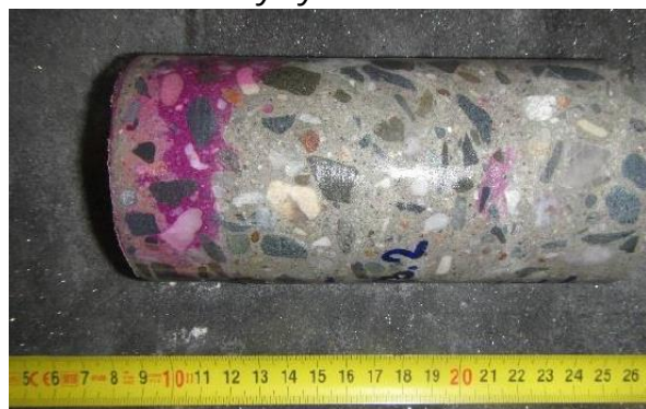
Obrázek 121: Laboratorní foto odebraného vzorku betonu z vývrtu V1N1.1
