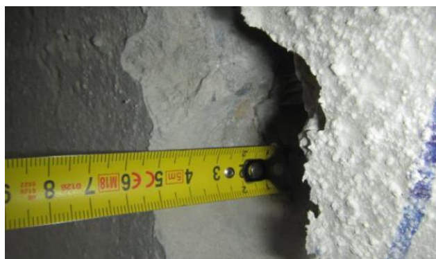
Obrázek 176: Detailní foto měření krycí vrstvy chráničky v místě sondy K1.1
