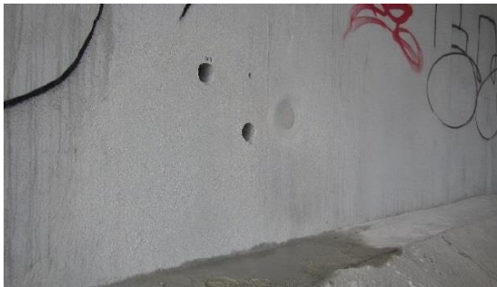
Obrázek 59: Celkový pohled na místo odběru vývrtu V1OP1
