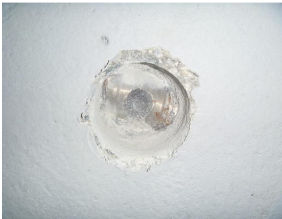
Obrázek 165: Pohled na místo provedení sondy K2.7
