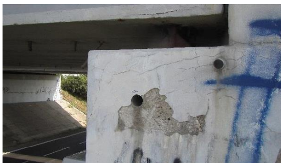
Obrázek 71: Celkový pohled na místo odběru vývrtu V2ÚP1
