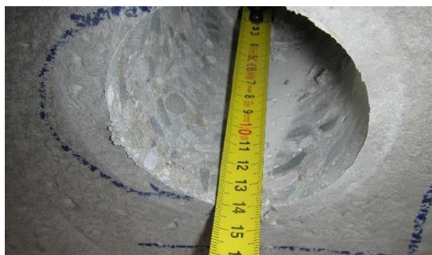
Obrázek 127: Detailní foto měření hloubky vývrtu V1N2.10
