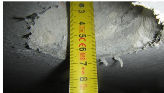
Obrázek 187: Detailní foto měření krycí vrstvy chráničky v místě sondy K1.9
