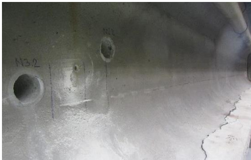
Obrázek 122: Celkový pohled na místo odběru vývrtu V2N1.1
