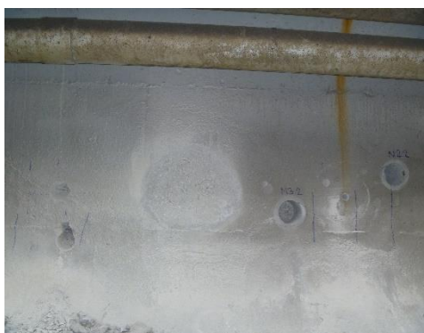
Obrázek 175: Pohled na místo provedení sondy K1.1
