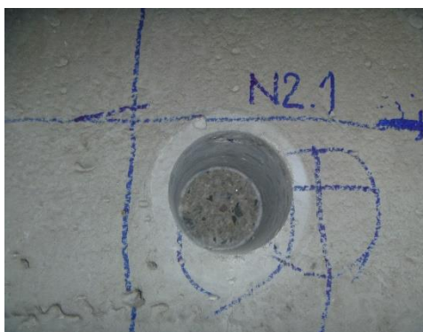
Obrázek 130: Celkový pohled na místo odběru vývrtu V2N2.10
