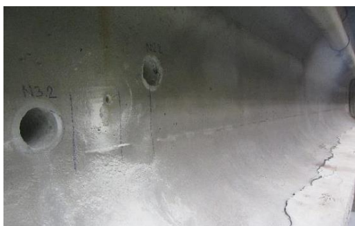
Obrázek 118: Celkový pohled na místo odběru vývrtu V1N1.1
