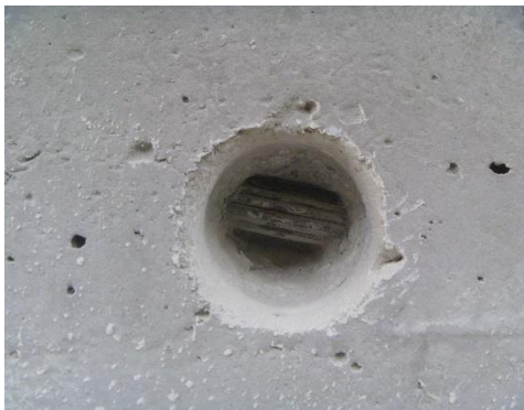
Obrázek 172: Pohled na místo provedení sondy K2.10
