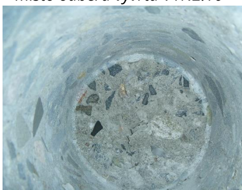
Obrázek 128: Detailní foto ostění vývrtu V1N2.10
