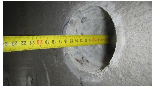
Obrázek 123: Detailní foto měření hloubky vývrtu V2N1.1
