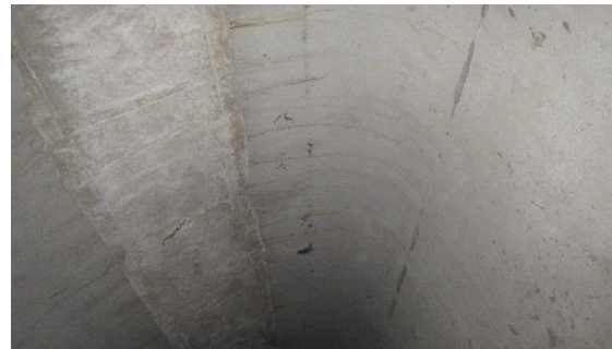
Obrázek 143: Pohled na horní dobetonávku místem odběru vývrtu VS2.1-2.2
