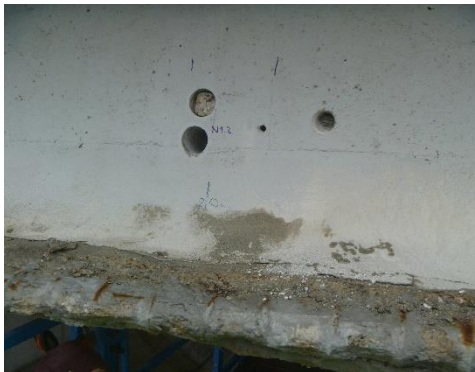
Obrázek 114: Celkový pohled na místo odběru vývrtu VN1.10
