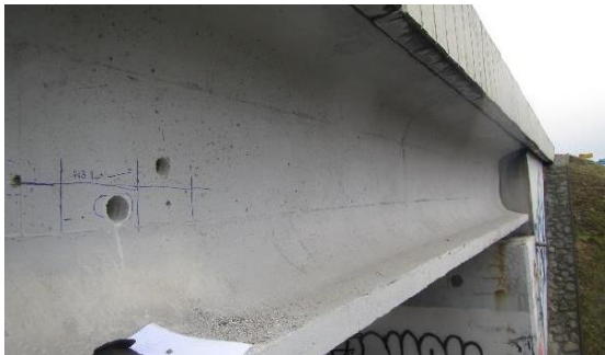
Obrázek 134: Celkový pohled na místo odběru vývrtu VN2.1
