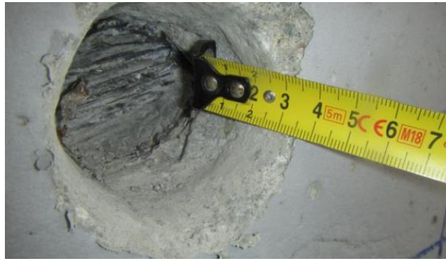
Obrázek 157: Detailní foto měření krycí vrstvy chráničky v místě sondy K2.1
