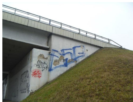
Obrázek 43: Pohled na levé křídlo Brněnské opěry
