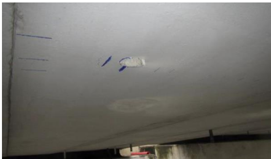
Obrázek 178: Pohled na místo provedení sondy K1.2
