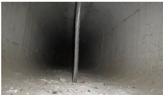
Obrázek 149: Pohled do dutiny místem odběru vývrtu VS1.1-1.2
