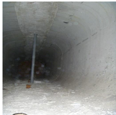
Obrázek 152: Pohled do dutiny místem odběru vývrtu VS1.9-1.10
