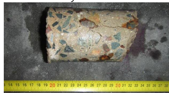
Obrázek 148: Laboratorní foto odebraného vzorku betonu z vývrtu VS2.9-2.10
