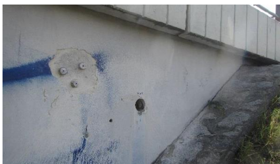
Obrázek 75: Celkový pohled na místo odběru vývrtu VK1
