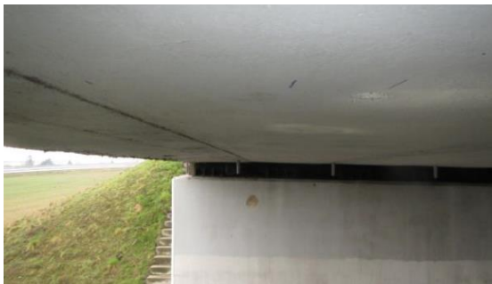
Obrázek 186: Pohled na místo provedení sondy K1.9
