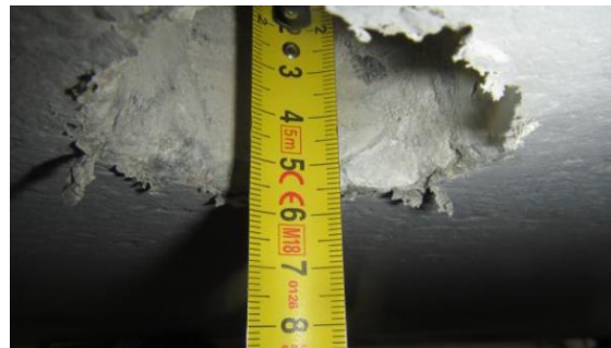
Obrázek 160: Detailní foto měření krycí vrstvy chráničky v místě sondy K2.3
