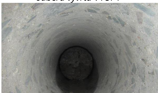
Obrázek 69: Detailní foto ostění vývrtu V1ÚP1
