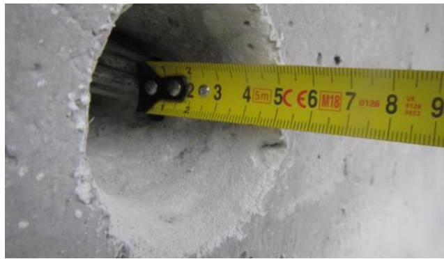
Obrázek 173: Detailní foto měření krycí vrstvy chráničky v místě sondy K2.10
