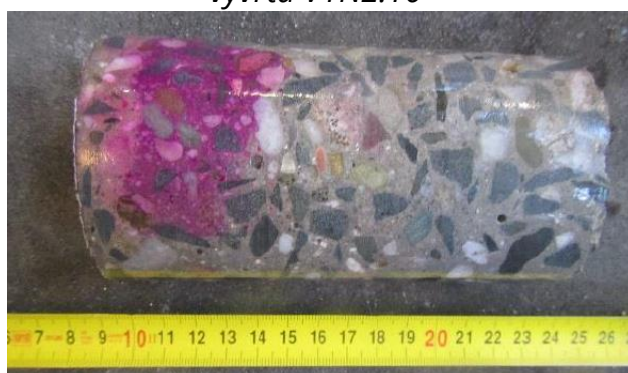
Obrázek 129: Laboratorní foto odebraného vzorku betonu z vývrtu V1N2.10
