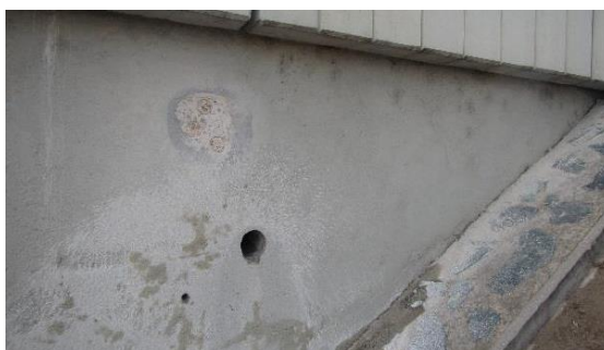
Obrázek 103: Celkový pohled na místo odběru vývrtu VK4
