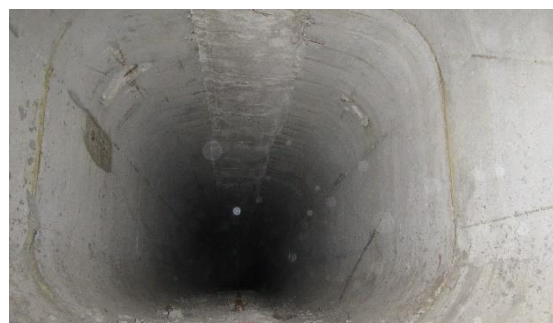
Obrázek 19: Pohled do dutiny – povrch dobetonávky nosníků bez koroze
