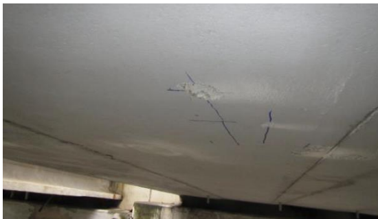
Obrázek 169: Pohled na místo provedení sondy K2.9
