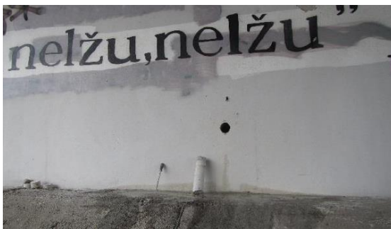
Obrázek 87: Celkový pohled na místo odběru vývrtu V2OP2
