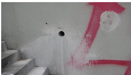
Obrázek 79: Celkový pohled na místo odběru vývrtu VK2
