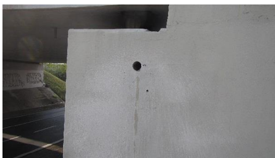
Obrázek 91: Celkový pohled na místo odběru vývrtu V1ÚP2
