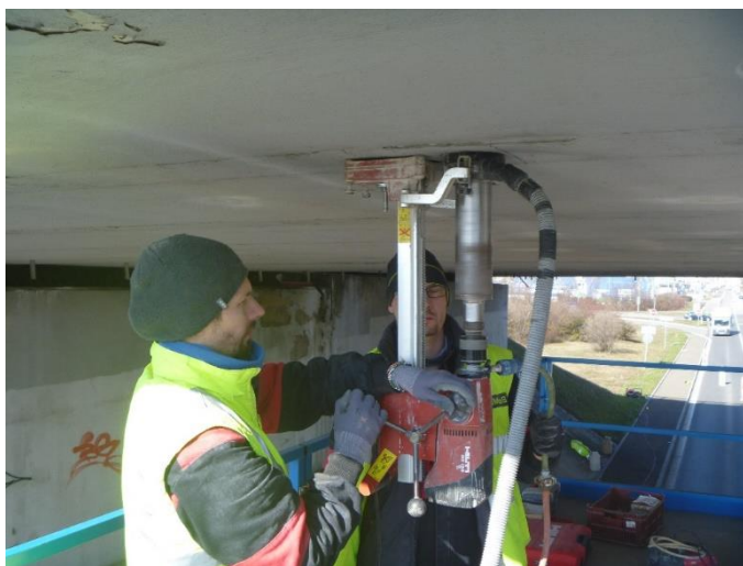
Obrázek 50: Odebírání jádrového vývrtu z dobetonávky mezi nosníky 1.9 a 1.10
