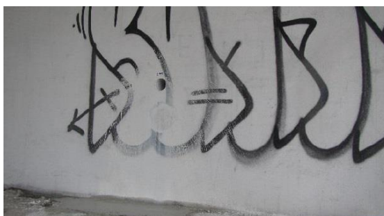
Obrázek 63: Celkový pohled na místo odběru vývrtu V2OP1
