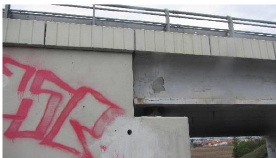
Obrázek 67: Celkový pohled na místo odběru vývrtu V1ÚP1
