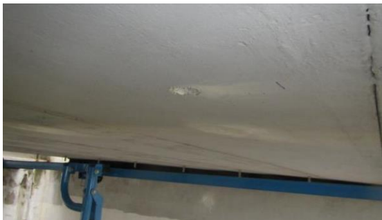
Obrázek 159: Pohled na místo provedení sondy K2.3
