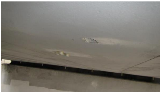
Obrázek 162: Pohled na místo provedení sondy K2.5
