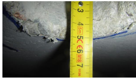
Obrázek 179: Detailní foto měření krycí vrstvy chráničky v místě sondy K1.2
