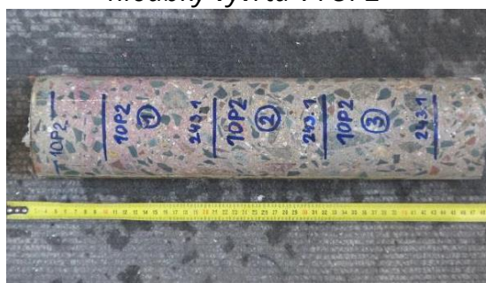
Obrázek 86: Laboratorní foto odebraného vzorku betonu z výtvtu V1OP2
