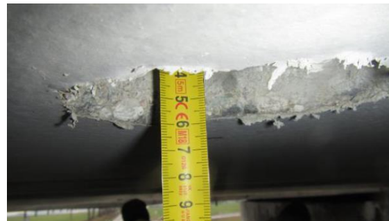
Obrázek 163: Detailní foto měření krycí vrstvy chráničky v místě sondy K2.5
