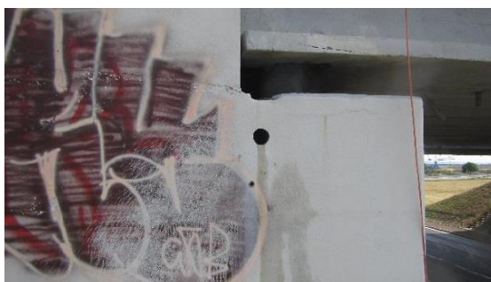
Obrázek 95: Celkový pohled na místo odběru vývrtu V2ÚP2
