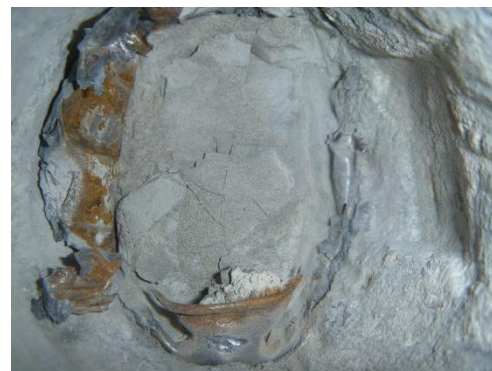
Obrázek 15: Pohled do proinjektované chráničky
