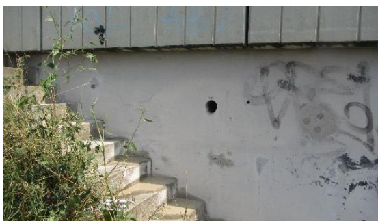
Obrázek 99: Celkový pohled na místo odběru vývrtu VK3
