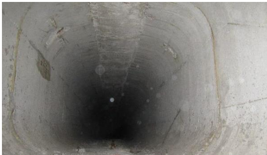
Obrázek 142: Pohled do dutiny místem odběru vývrtu VS2.1-2.2
