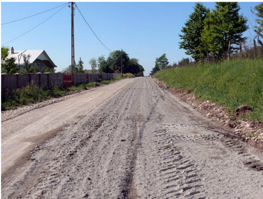
Obr. 2.11: Úprava podkladových vrstiev [21]
