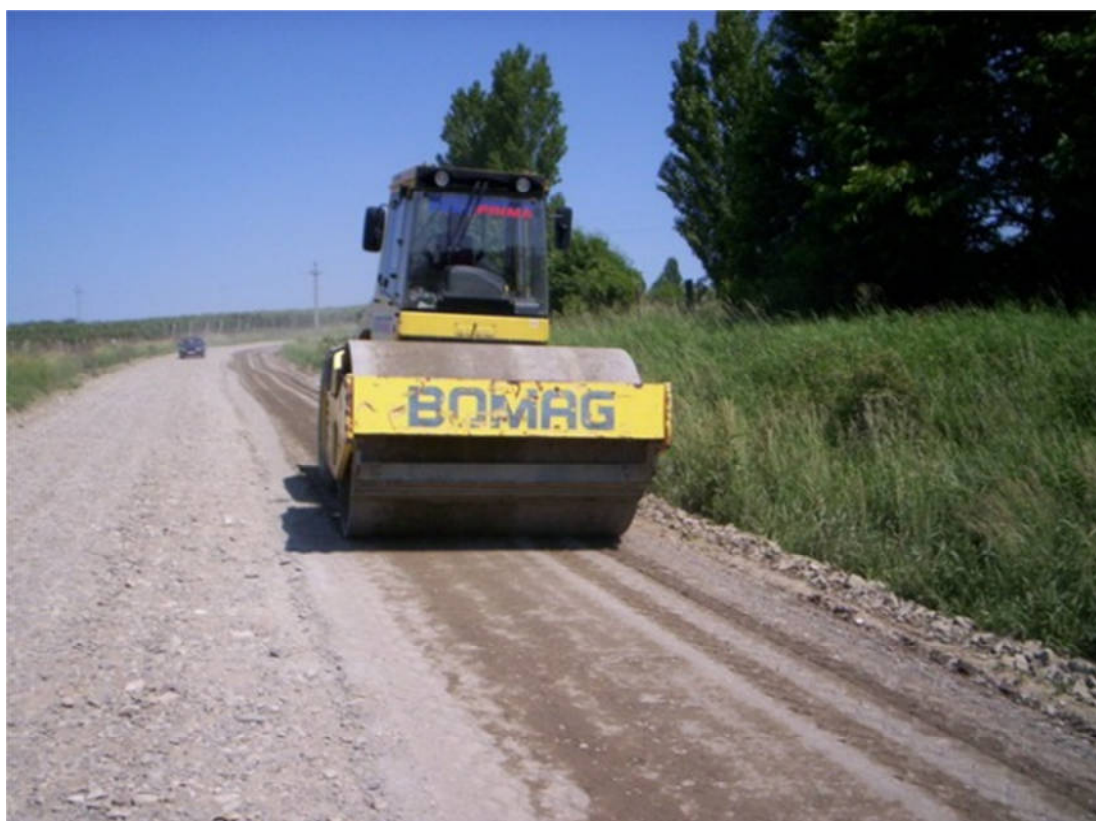
Obr. 2.12: Úprava podkladových vrstiev [21]
