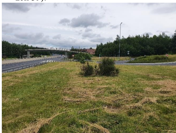
Obrázek 57 - Kruhový objezd u čerpací stanice
