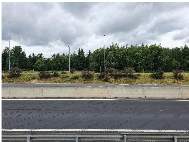
Obrázek 59 - Protější strana dálnice D6
