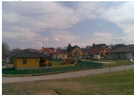
Obr. 28: Výstavba nových domů na jihozápadě Solnice
