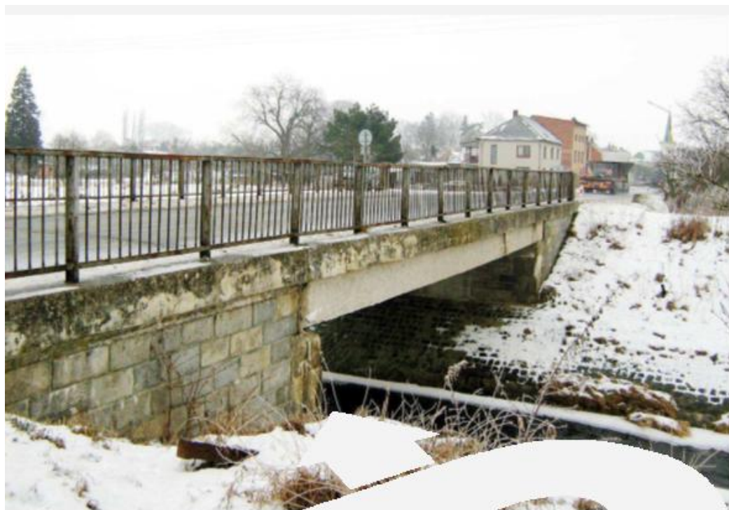
Obr. 7: Původní stav mostu[19]
