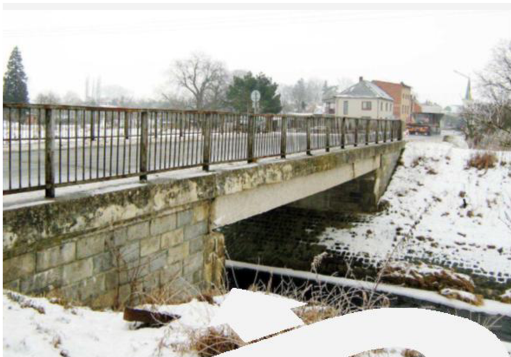
Obr. 7: Původní stav mostu[19]
