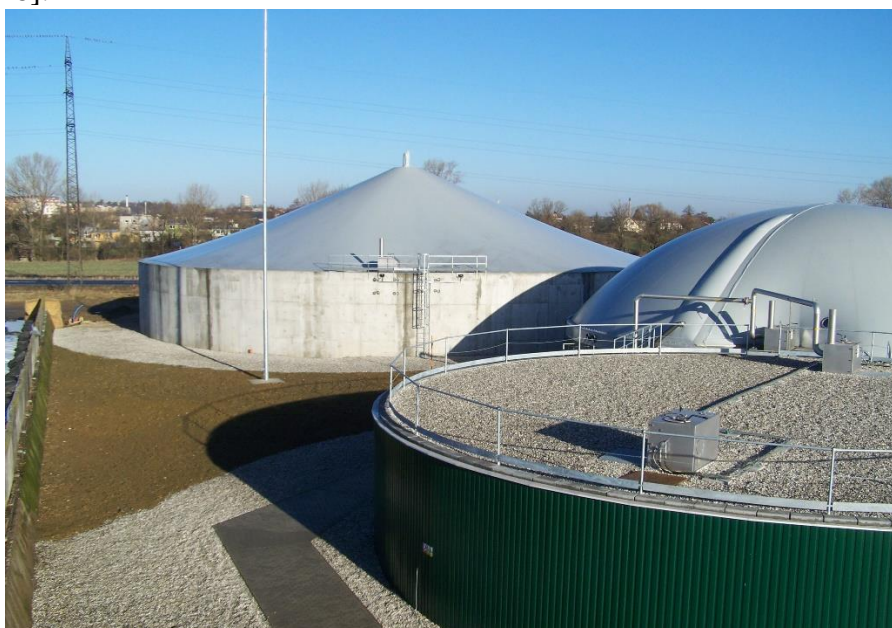
obr. 1: Zemědělská bioplynová stanice Kylešovice [19]
