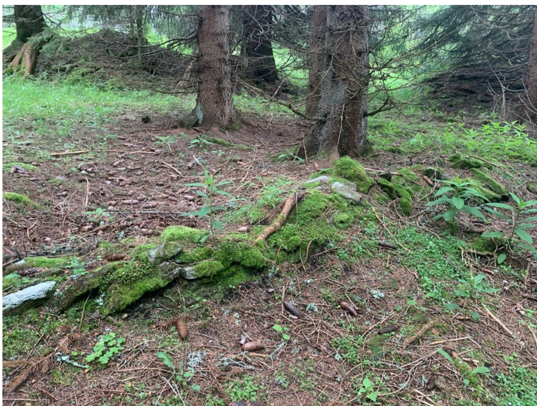
Obr. č. 41 a č. 42 Zbytky základů objektů porostlé vegetací (zdroj:vlastní)
