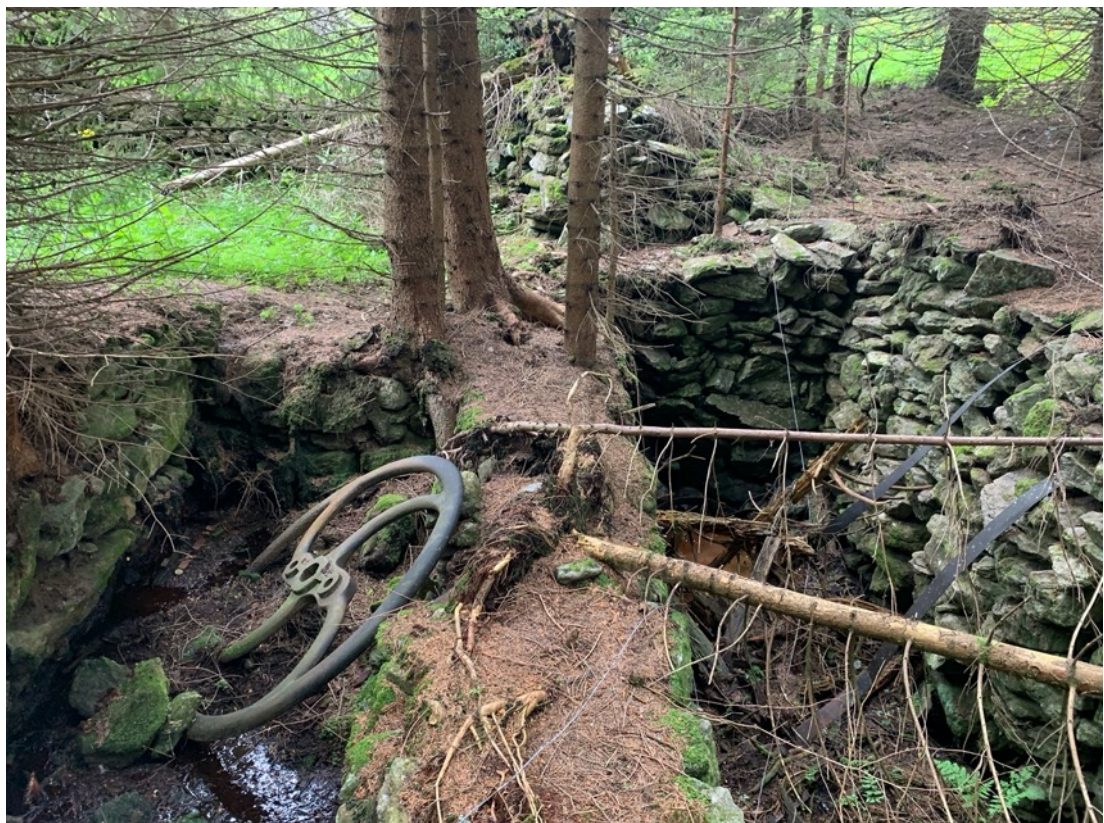
Obr. č. 55 a č. 57 Zachycená lednice, ve které pracovala mlynářská kola. Na obr. č. jsou po pravé straně vidět další listy katru (zdroj: vlastní)
