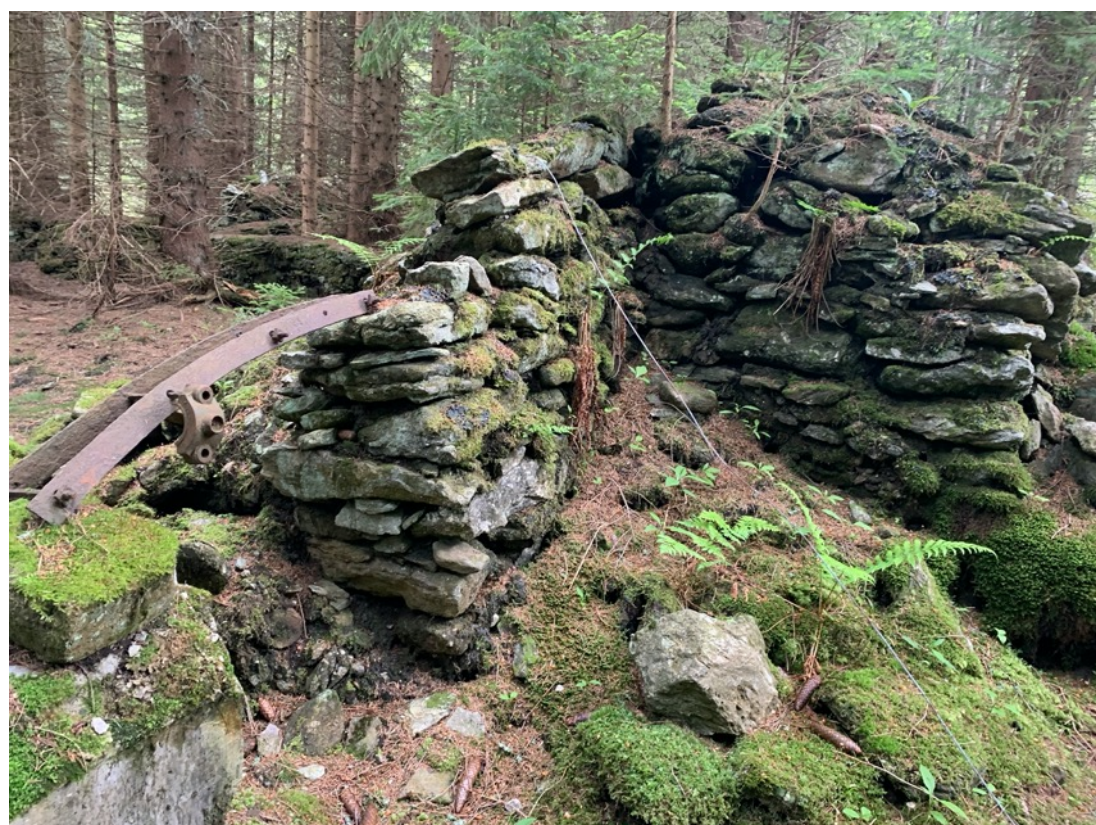
Obr. č. 53 Zachovalý list katru a v pozadí je vidět koryto v němž tekla voda v dobách, kdy mlýn s pilou pracoval (zdroj: vlastní)
