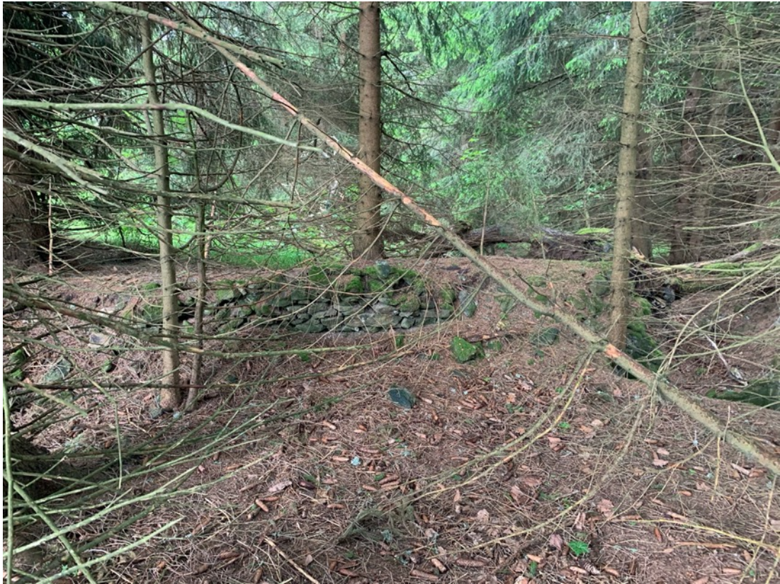
Obr. č. 65 Hráz retenční nádrže, pohled z boku (zdroj: vlastní)
