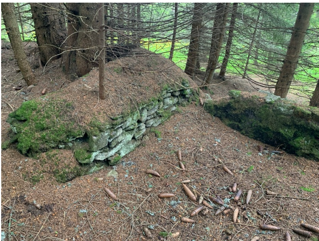
Obr. č. 49 a č. 50 Rozvaliny pily (zdroj: vlastní)
