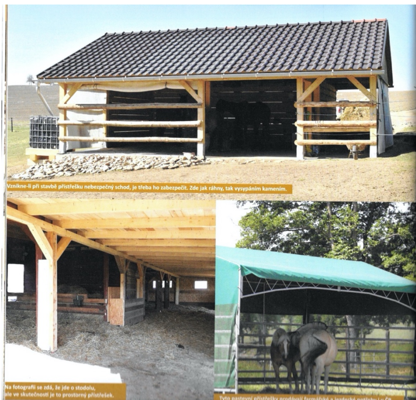
Obrázek 6: existuje mnoho typů přístřešků, na horním obrázku můžeme vidět dřevěný přístřešek, vlevo využití stodoly pro přístřešek, vpravo pak mobilní přístřešek. (Jebáčková-Lazanská, 2020)
