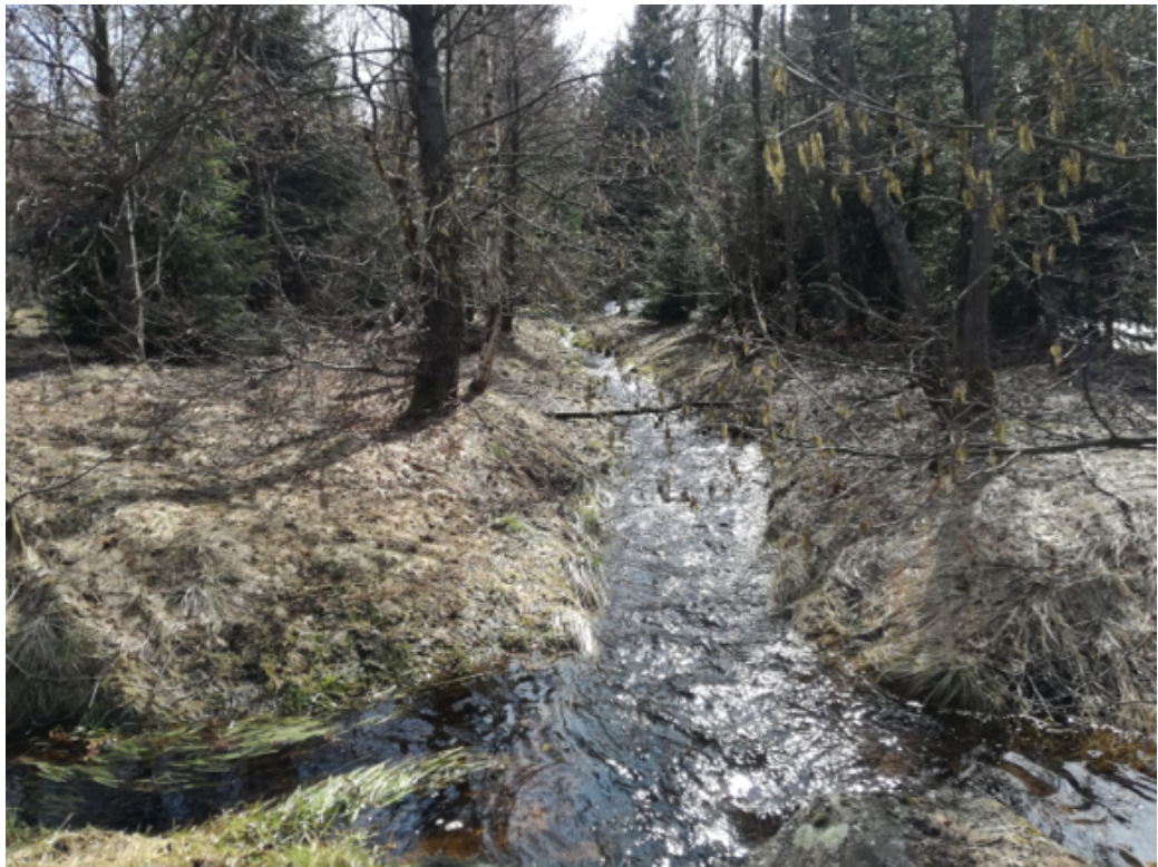
Příloha č. 32 – Odvodňovací kanál, Jindřichova ves (Zdroj: Autor)
