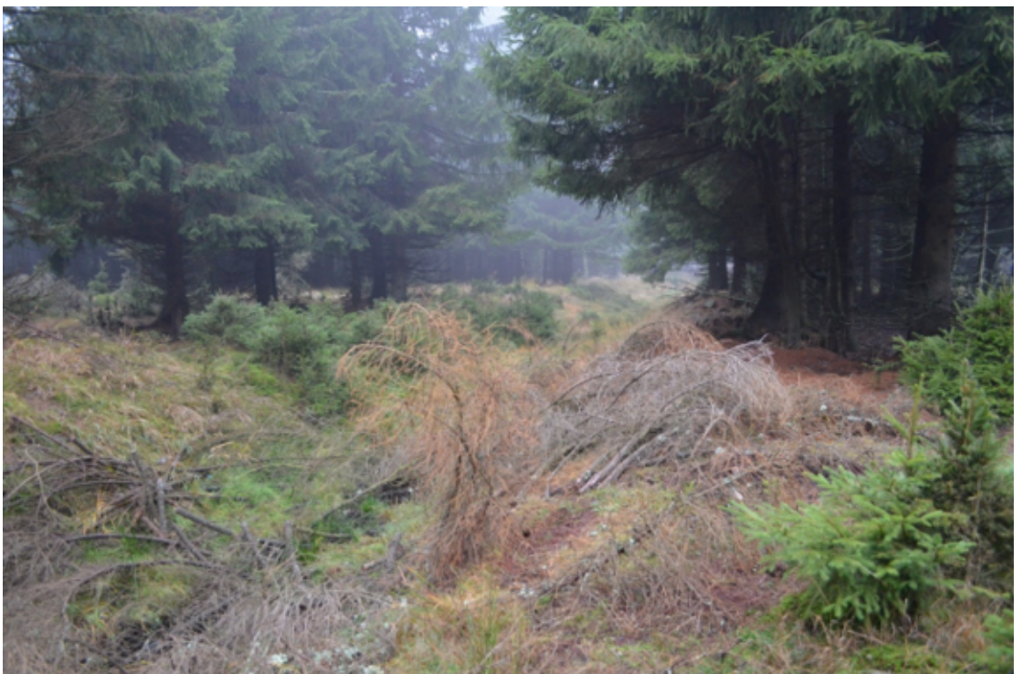
Příloha č. 10 – Odvodňovací kanál se silným znečištěním starými polomy, Hora sv. Šebestiána (Zdroj: Autor)
