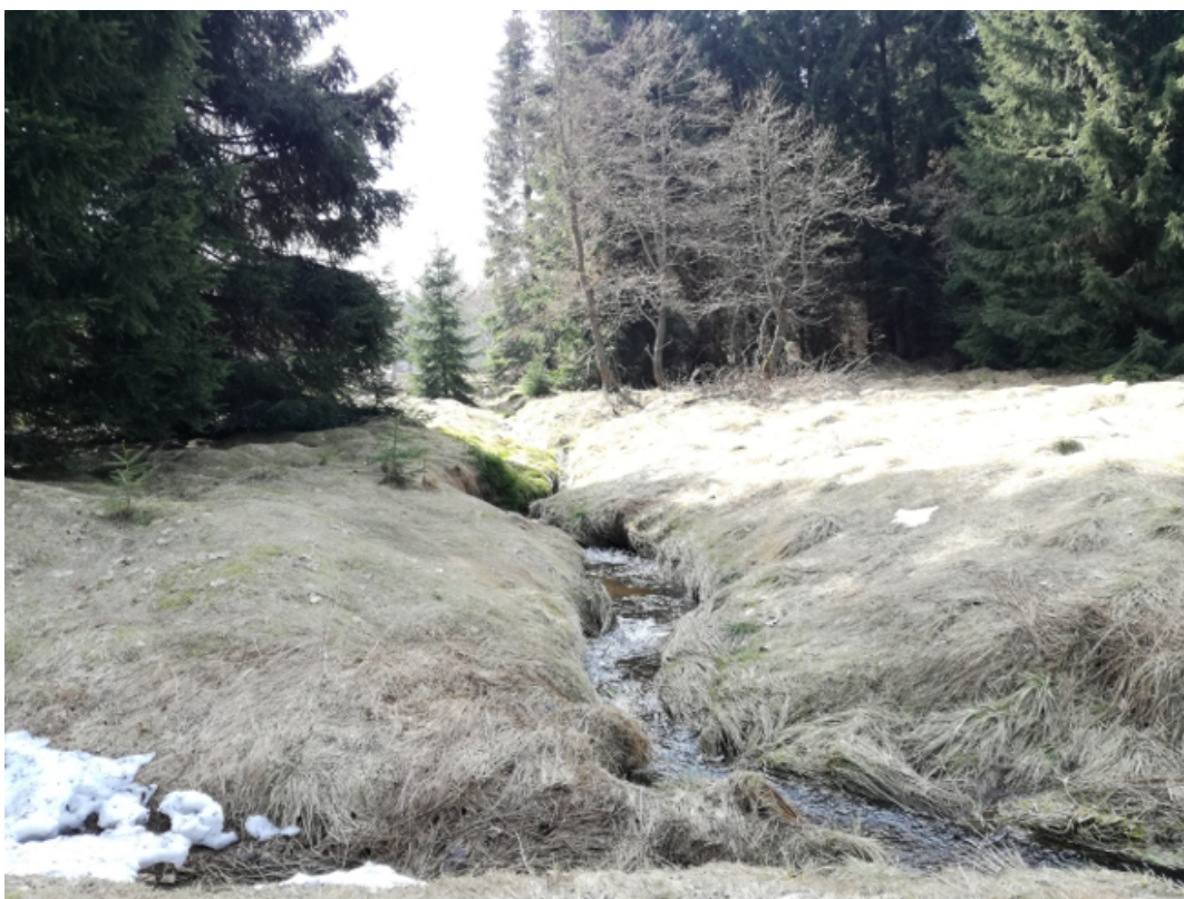
Příloha č. 36 – Odvodňovací kanál, Jindřichova ves (Zdroj: Autor)
