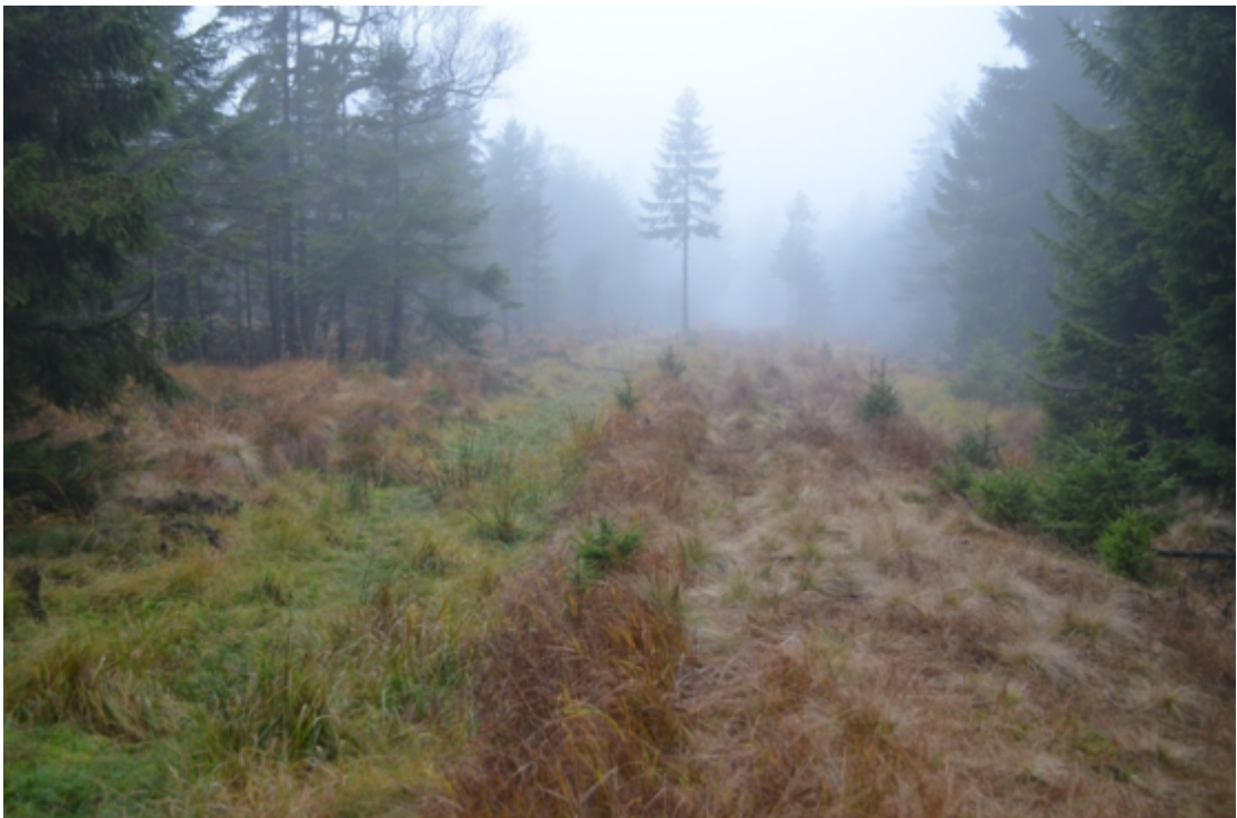
Příloha č. 14 – Hlavní odvodňovací kanál, Hora sv. Šebestiána (Zdroj: Autor)
