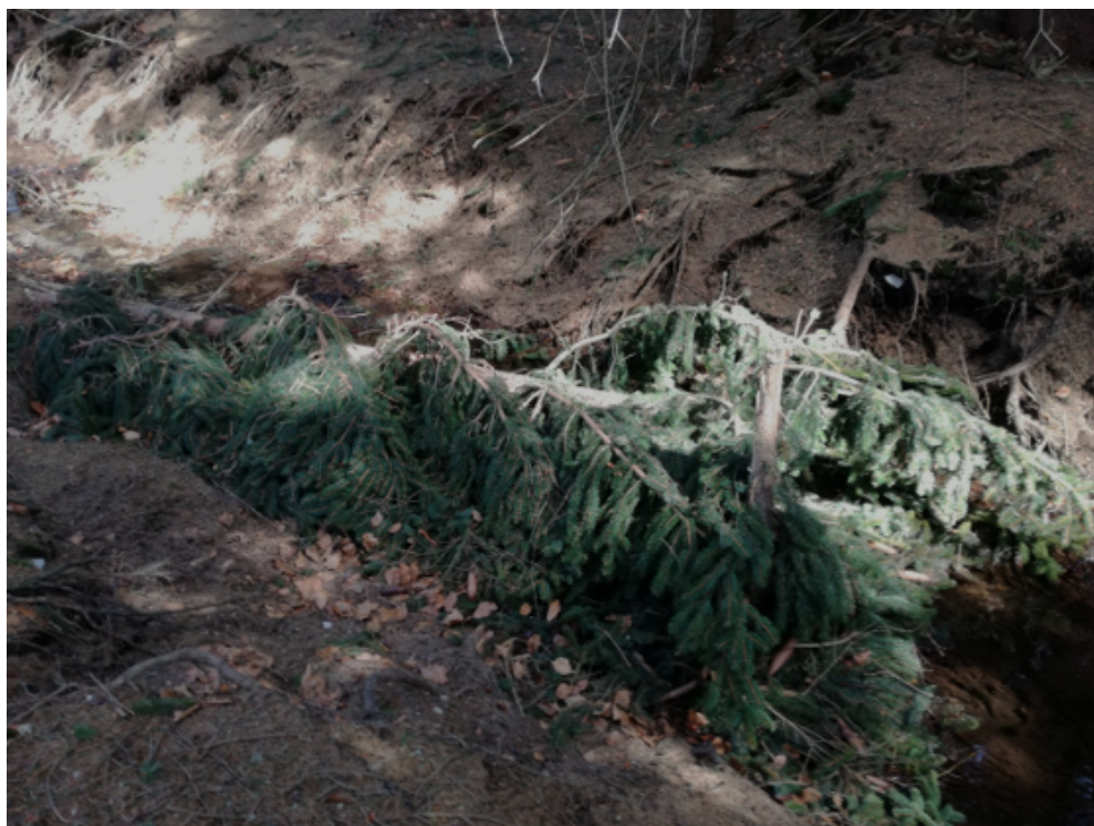
Příloha č. 23 – Polom uvnitř kanálu, Hora sv. Šebestiána (Zdroj: Autor)
