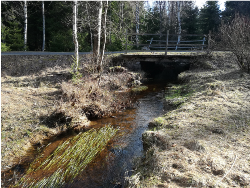
Příloha č. 25 – Hlavní odvodňovací kanál, Výsluní (Zdroj: Autor)
