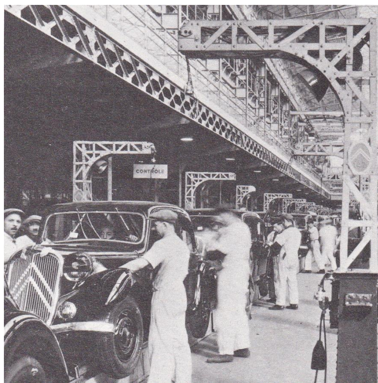
Obr. 18 Dokončovací práce na výrobní lince [26]
