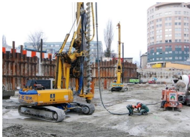
Obr. 13: Vrtací souprava Bauer BG 18H [15]
