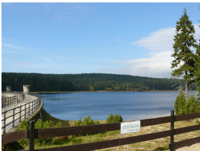
Obrázek 12. Hráz nádrže Bedřichov z návodní strany.
