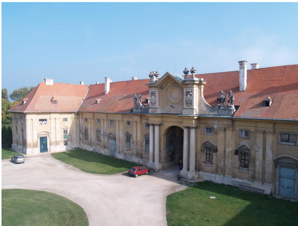
Obr. 29: Jízdárna Lednice – před rekonstrukcí
