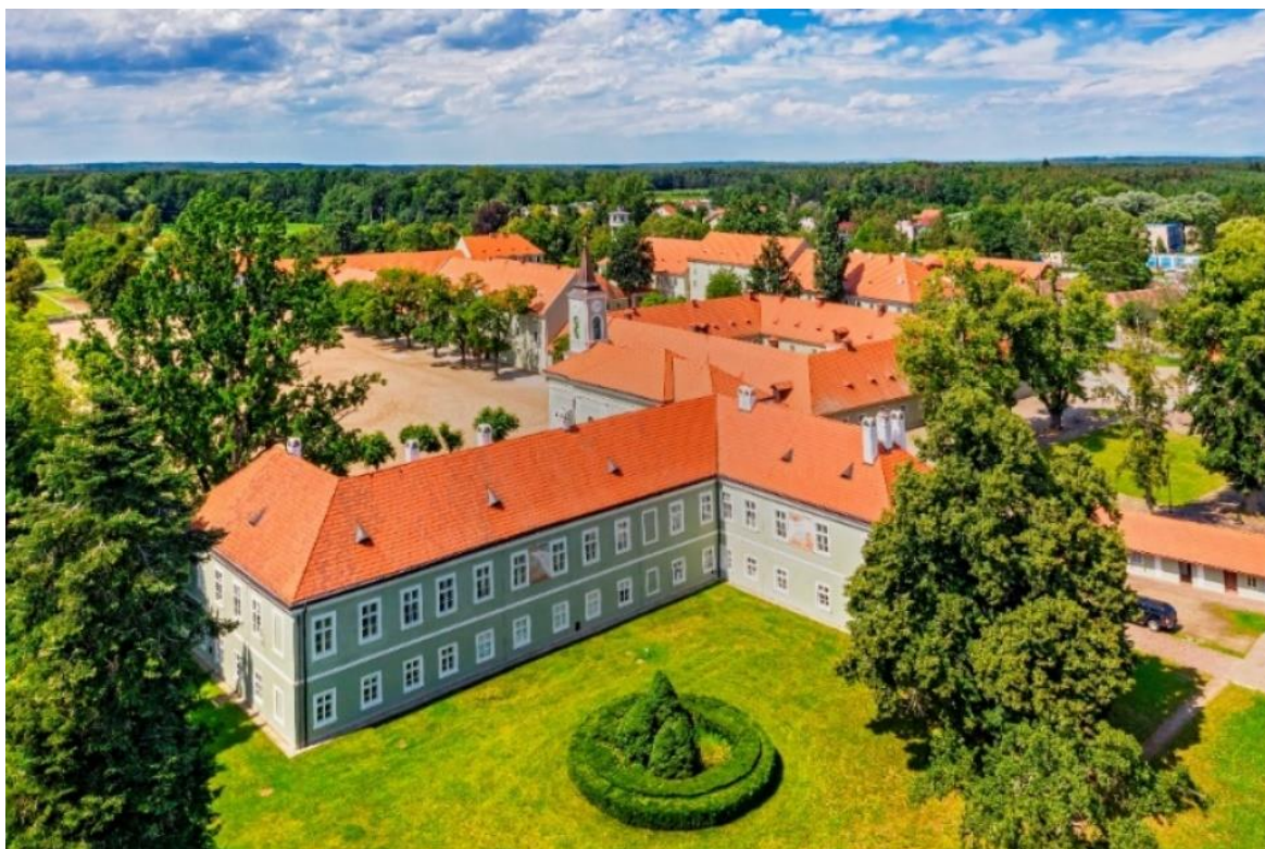
Obr. 10: Zámek Kladruby nad Labem po rekonstrukci
