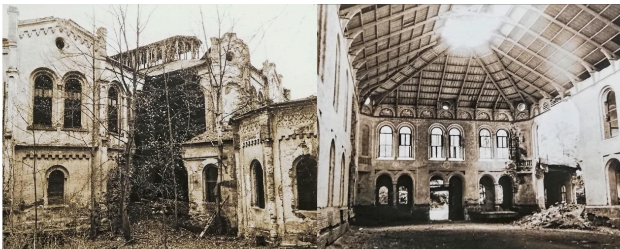
Obr. 42: Jízdárna Světce před rekonstrukcí
