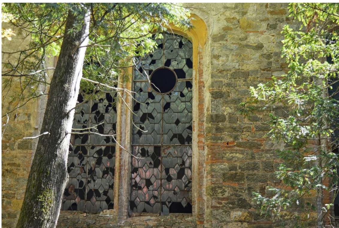
Obr. 47: Okna - jízďárna Hrádek u Nechanic
