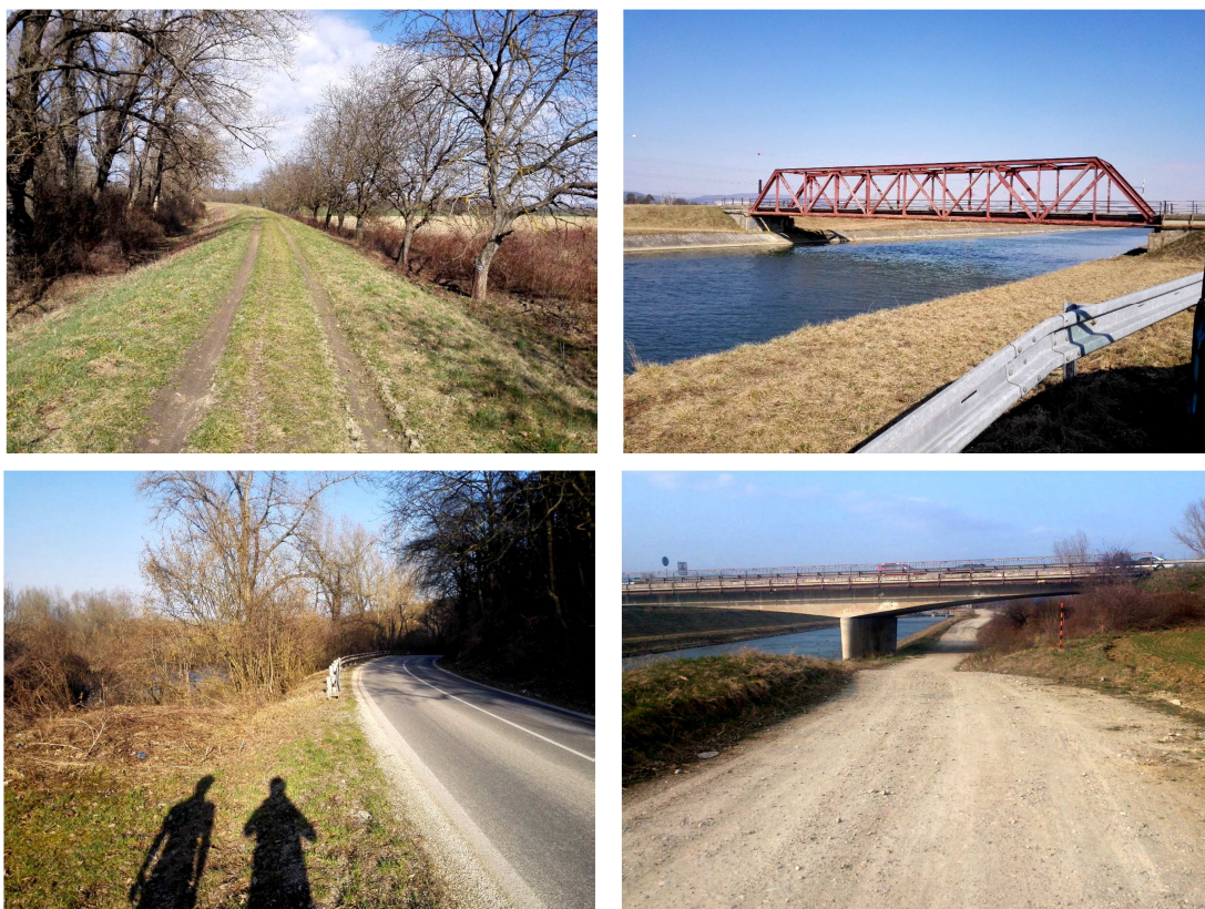
Obr. 2 Potenciálne miesta realizácie (1. Hrádza Opatovce-Trenčín, 2. Premostenie cez kanál Trenčín-Dubnica n/V, 3. Súbeh s cestou pri Beckove, 4. Podjazd pri Púchove) [15]
