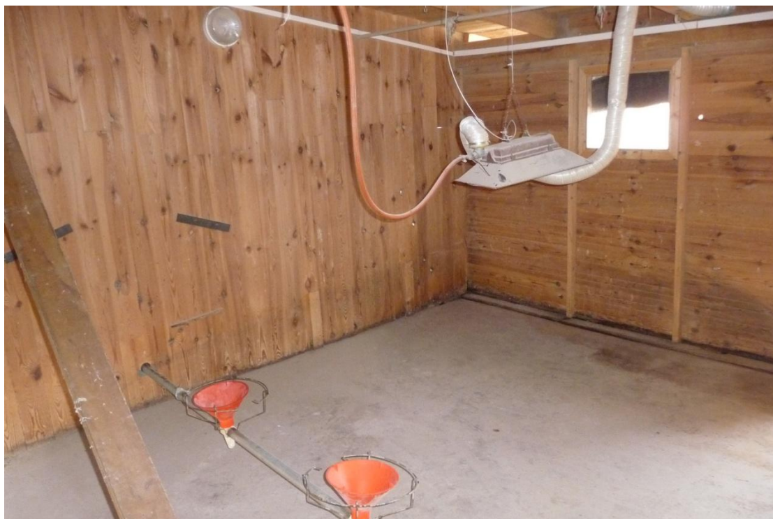
Obr. 3: Komorová odchovna s krmnou linkou a plynovým keramickým zářičem
