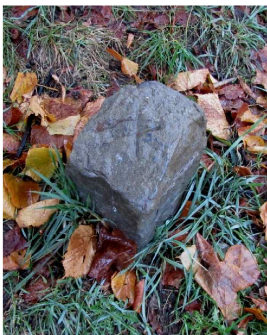
Obr. č.6 – Stabilizace kamenným hranolem
