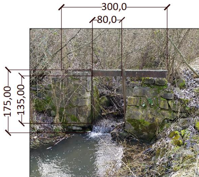
Obrázek 5.13 Objekt na toku – stavidlo, km 0,015 (autorka, 2020)
