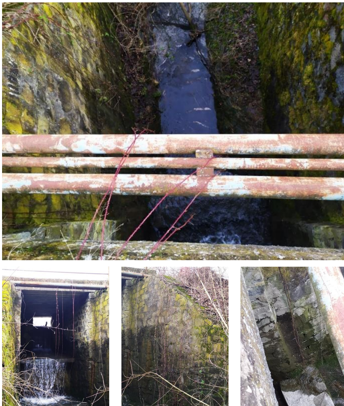
Obrázek č. 6 Spodní výpust, MVN Hradisko (autorka, 2020)
