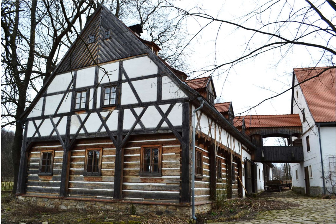
Obr. 35: Dům severních Čech s hrázděným patrem
