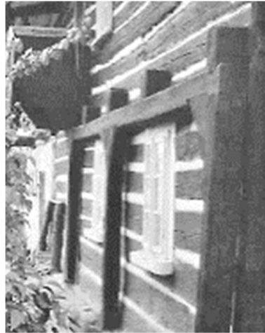
Obr. 22: Podstávka nesoucí stropní trámy (Vojtíšek a Vařeka, 1999)
