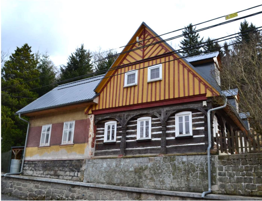
Obr. 34: Dům severních Čech – přízemní
