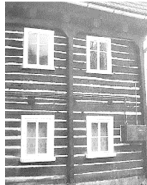
Obr. 24: Průběžná podstávka (Vojtíšek a Vařeka, 1999)
