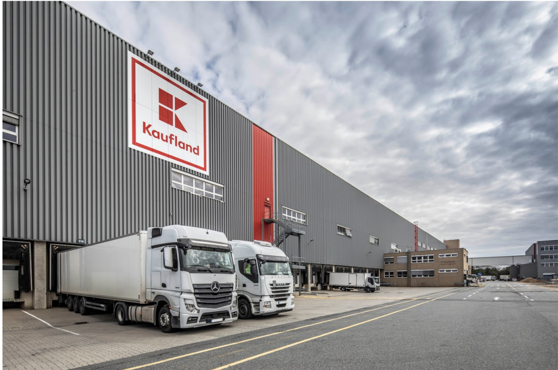
Obr. 2.2 Distribuční centrum v Modleticích
