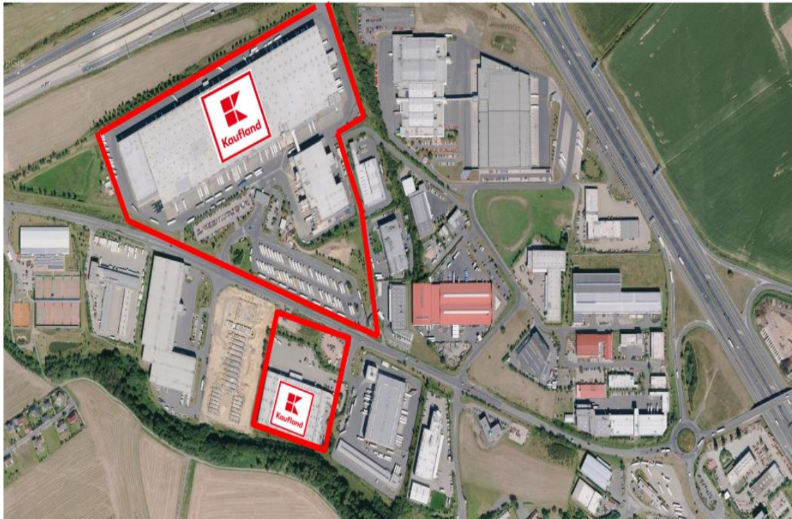
Obr. 2.1 Kaufland sklad hlavní budovy + sklad Tirex
