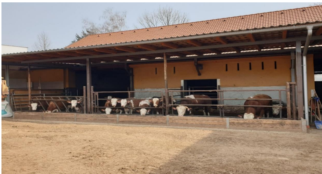
Obrázek 5: Nová střecha pořízená z dotace ze SZIF (zdroj: vlastní foto autora práce 2022)
