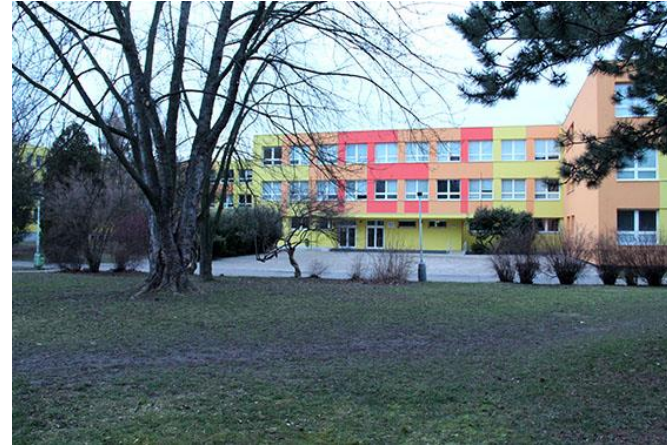
Obr. 29 – Hlavní vstup do školy (autorka, 2016)
