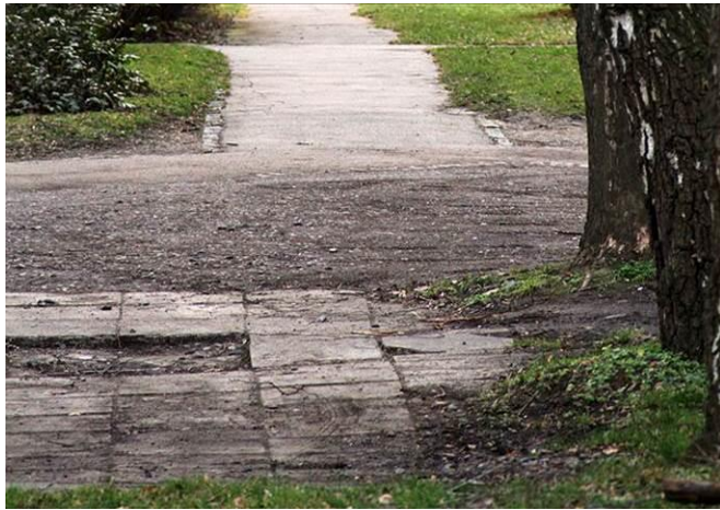
Obr. 40 – Zpevněné povrchy (autorka, 2016)
