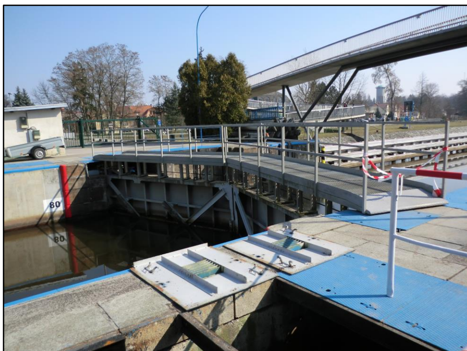
Obrázek 5 Plavební komora - vzpěrná vrata 27.7.2014 Foto: archiv Povodí Labe s.p.
