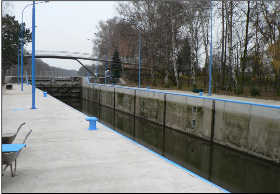
Obrázek 8 Opravená plavební komora 28.11.2006 Foto: archiv Povodí Labe s.p.
