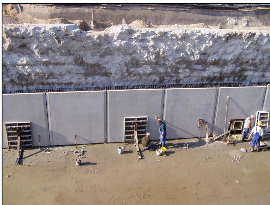
Obrázek 7 Nová spodní řada panelů Foto: archiv Povodí Labe s.p.
