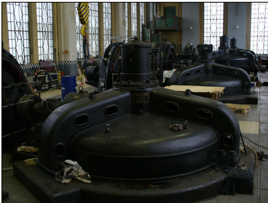
Obrázek 13 Nadzemní část stroje 21.3.2015 Foto: M.Bubanec
