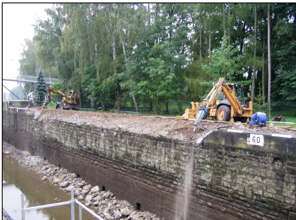
Obrázek 6 Bourání kamenného obkladu a betonu Foto: archiv Povodí Labe s.p.
