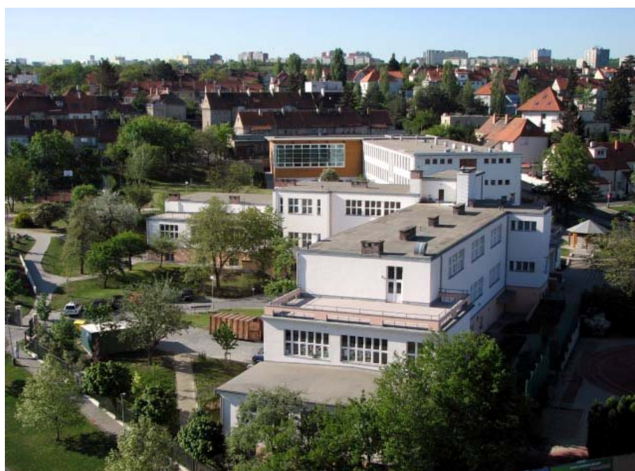
Obrázek 2: ZŠ Jižní, pohled na celou školu
