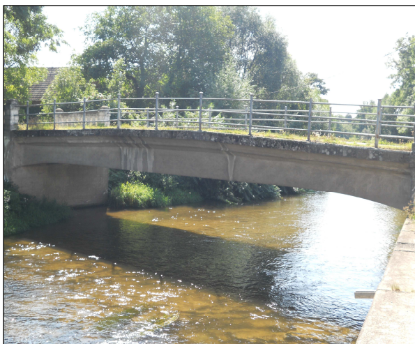
Obr. č. 26 Dnešní betonový most v Dolsku
