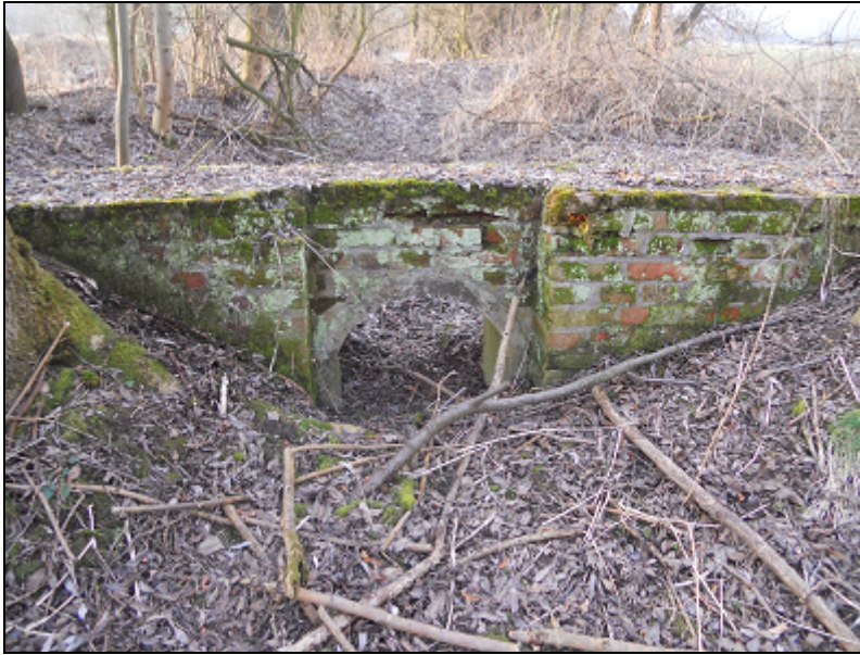
Obr. č. 3 Stavidlo závlahového systému
