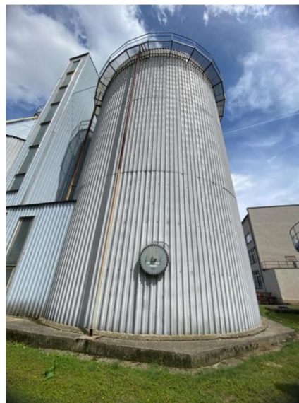
Obr. 25: Uskladňovací nádrž (zdroj:vlastní).
