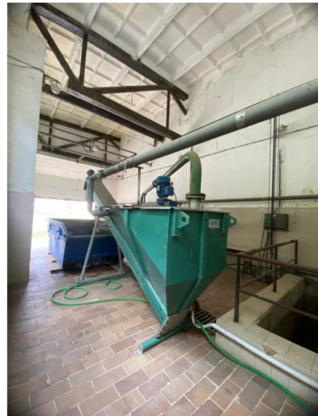
Obr. 10: Separátor s praním písku a kontejnerem (zdroj: vlastní).
