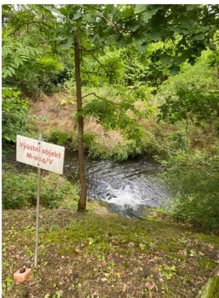
Obr. 20: Výústní objekt (zdroj: vlastní).
