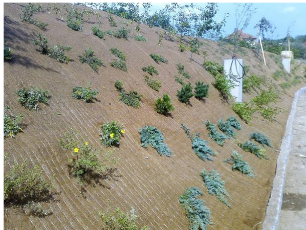
Obrázek 3: Kokosová rohož jako dočasné protierozní řešení
