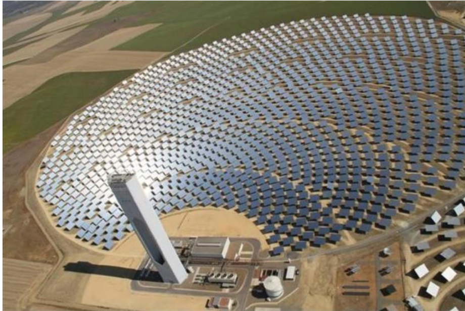
Obr.11 Solární elektrárna instalovaná společností Abengoa [7]
