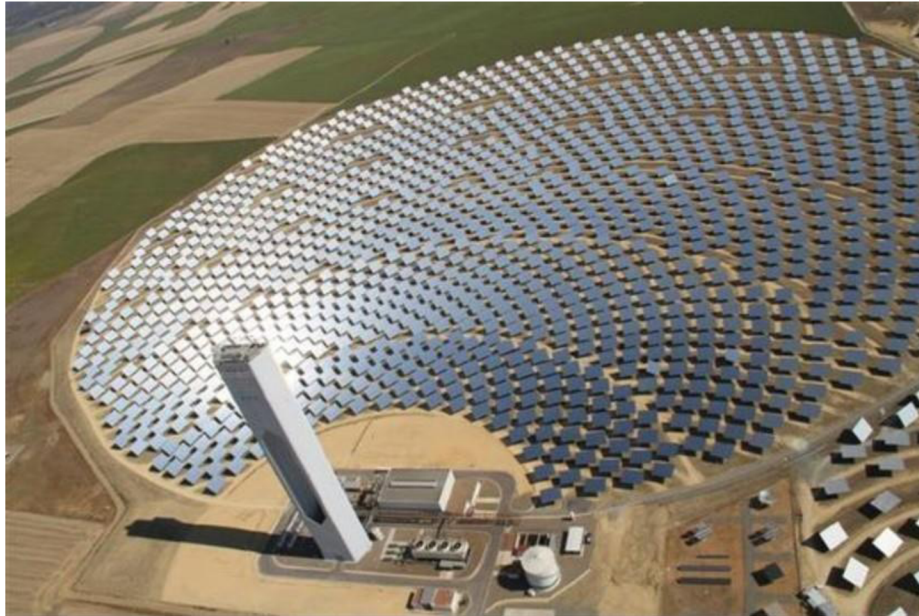
Obr.11 Solární elektrárna instalovaná společností Abengoa [7]
