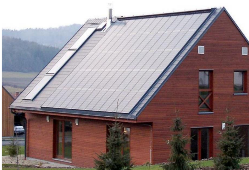
Obr. 10 Sedlová střecha se standardními moduly [9]
