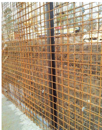
Obrázok F.2 – Osadenie tesniaceho plechu ASS do obv. steny [14]
