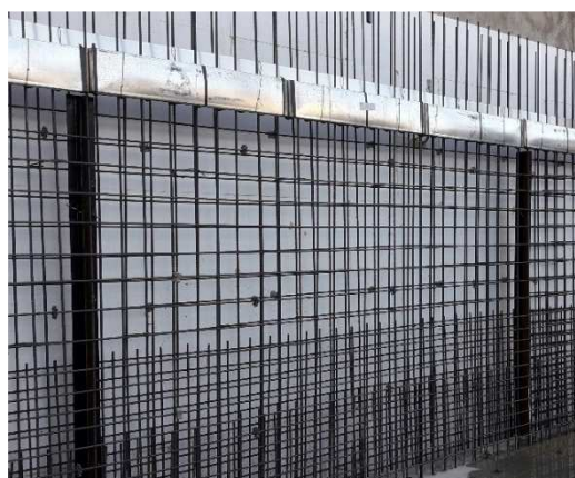
Obrázok F.4 – Osadenie vylamovacej výstuže, tesnicich prvkov VB1 a ASS
