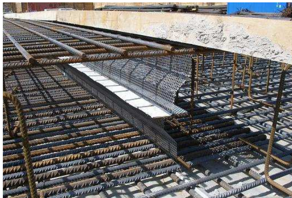
Obrázok E.3 – Osadenie tesniaceho plechu ABS [14]
