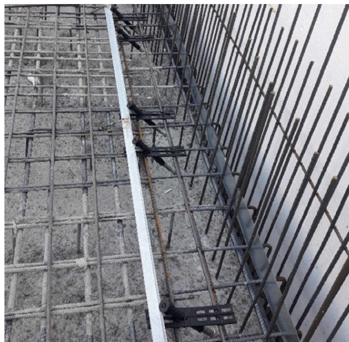
Obrázok E.10 – Rozmiestnenie kotiev V-Halter
