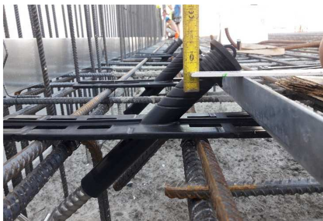
Obrázok E.11 – Detail osadenia kotvy V-Halter
