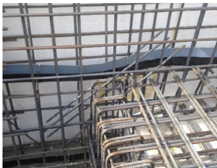
Obrázok E.6 – Osadenie tesniaceho plechu VB1
