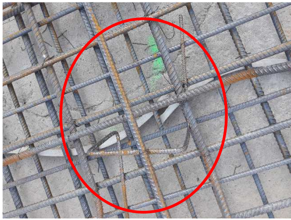
Obrázok E.5 – Dištančný prvok výstuže „kozička“
