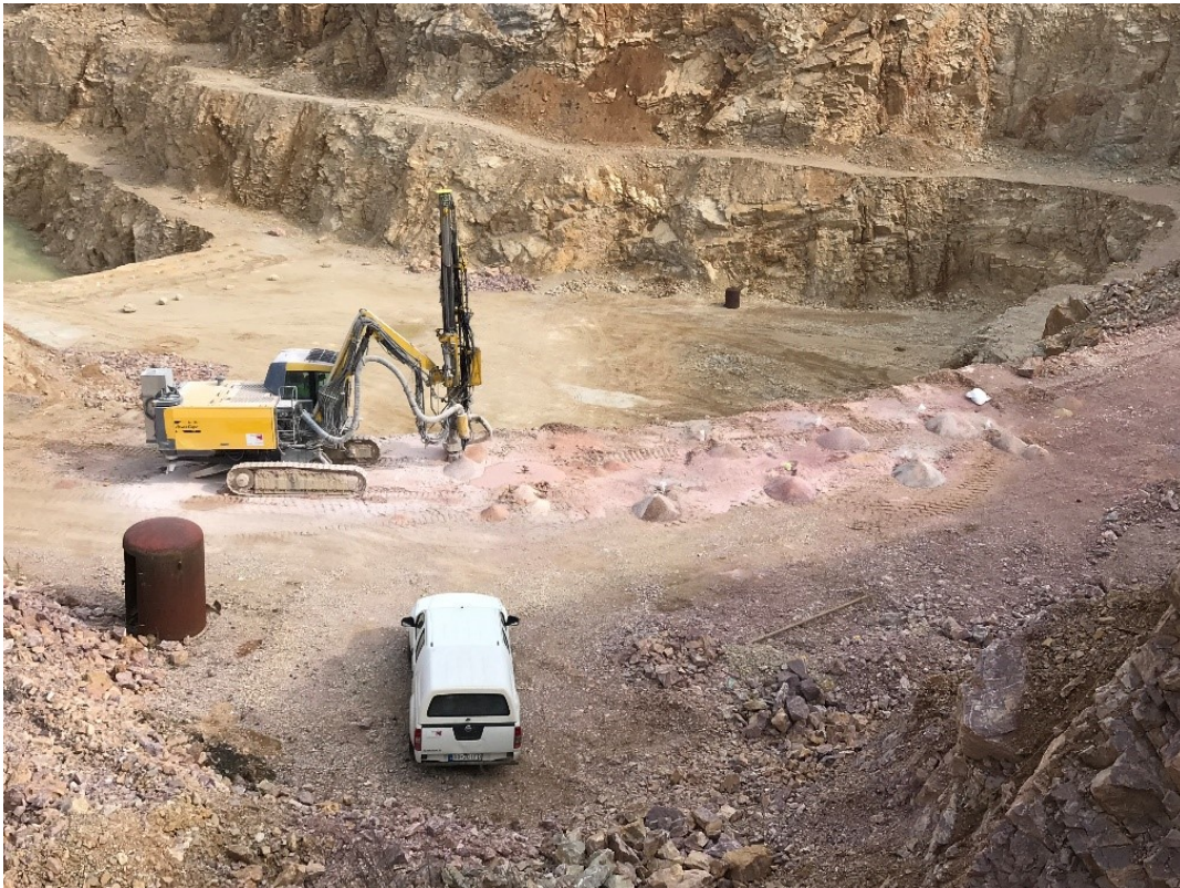
Obr. 3.2 Vŕtacie práce v kameňolome Pohranice
