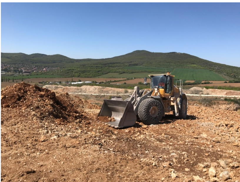
Obr. 3.1 Skrývkové práce v kameňolome Pohranice
