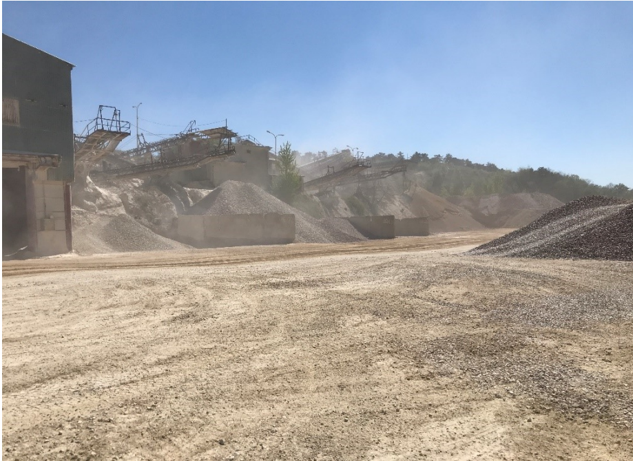
Obr. 3.7 Skládka hotových výrobkov
