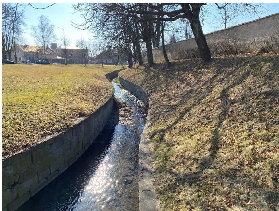
Obr. 26: Vodní tok Loučka veden v betonovém korytě v městě Lipník nad Bečvou, 2. 3. 2022; vlastní snímek
