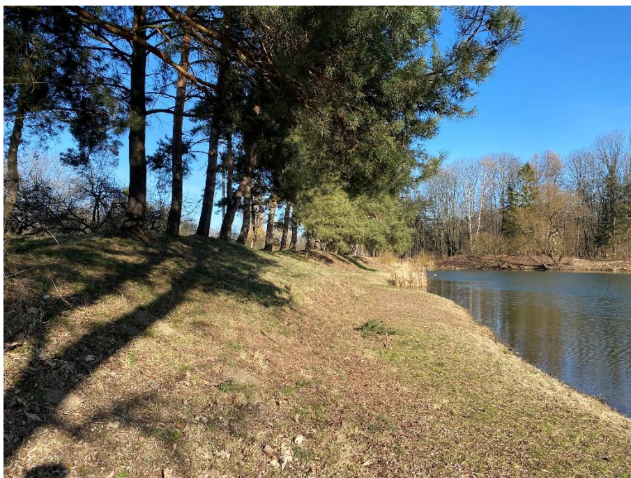
Obr. 48: Hráz vodní nádrže, 1. 3. 2022, vlastní snímek
