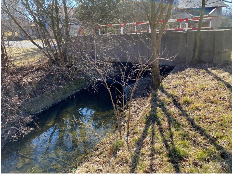
Obr. 19: Zpevnění břehu Trnávky u místního mostu, 13. 3. 2022; vlastní snímek
