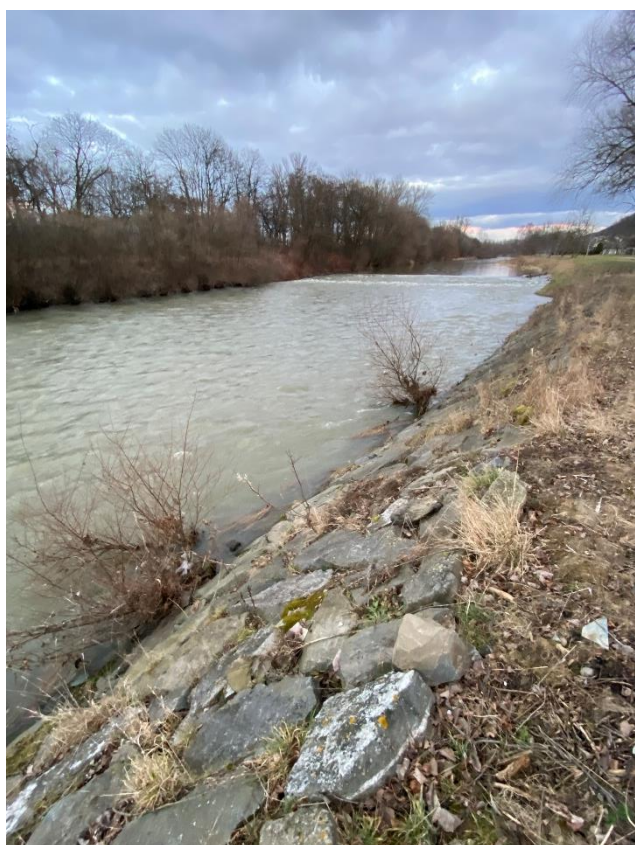
Obr. 12: Zpevněný břeh na hranici obcí Lipník nad Bečvou a Týn nad Bečvou 11. 2. 2022, vlastní snímek
