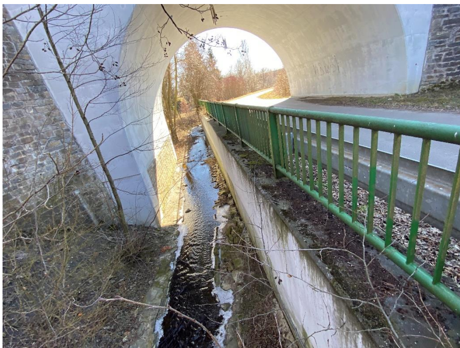
Obr. 30: Vodní tok Hlásenec pod železnicí, 13. 3. 2022; vlastní snímek
