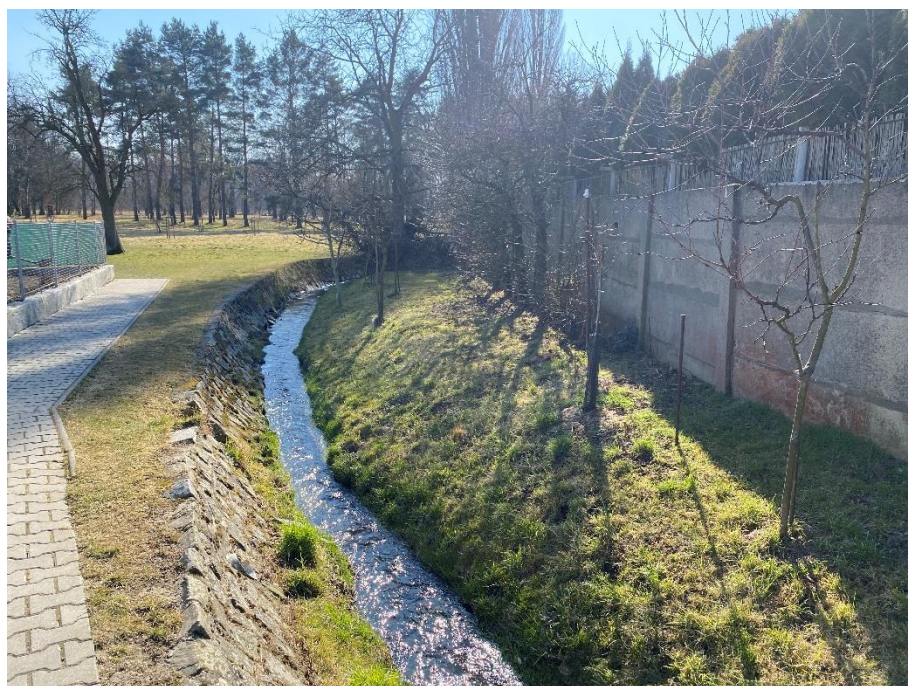
Obr. 28: Zpevnění levého břehu vodního toku Loučka vytékajícího ze zastavěného území, 2. 3. 2022; vlastní snímek
