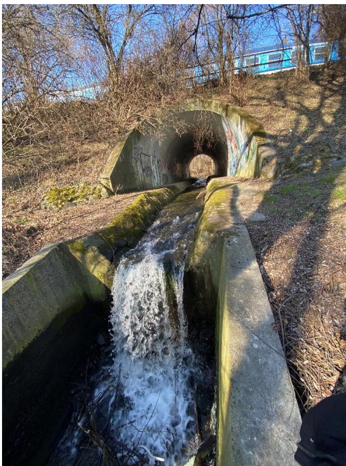
Obr. 23: Koryto vodního toku Loučka pod železnicí, 2. 3. 2022; vlastní snímek
