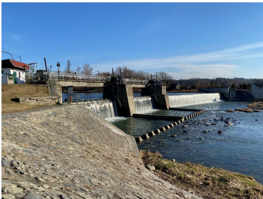
Obr. 14: Osecký jez, v pozadí malá vodní elektrárna, 10. 3. 2022; vlastní snímek
