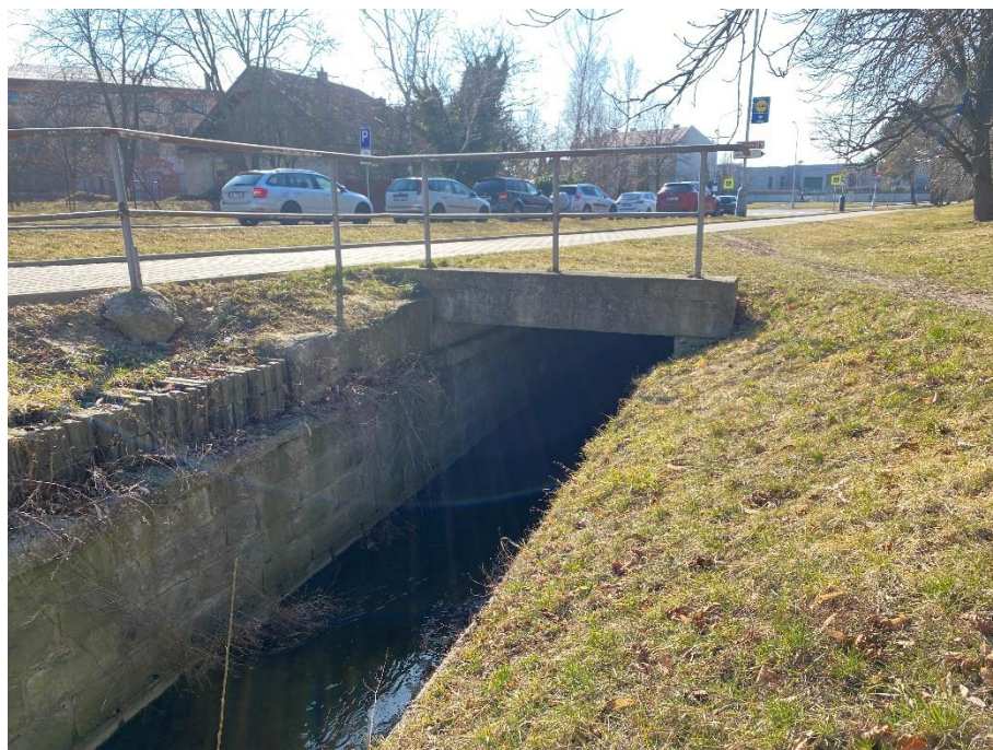
Obr. 27: Vodní tok Loučka veden pod zemským povrchem a v přilehlém betonovém korytě v městě Lipník nad Bečvou, 2. 3. 2022; vlastní snímek
