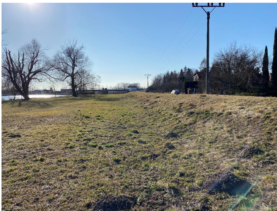
Obr. 17: Ochranná hráz u Oseckého jezu, 1. 3. 2022; vlastní snímek
