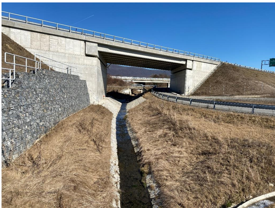
Obr.18: Napřímení Trnávky a vedení vodního toku v umělém korytě, 13. 3. 2022; vlastní snímek
