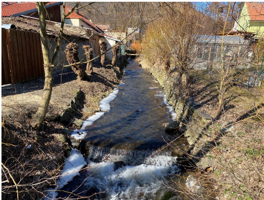
Obr. 31: Malý jez a zpevněné břehy na vodním toku Jezernice v městské části Podhoří, 13. 3. 2022; vlastní snímek
