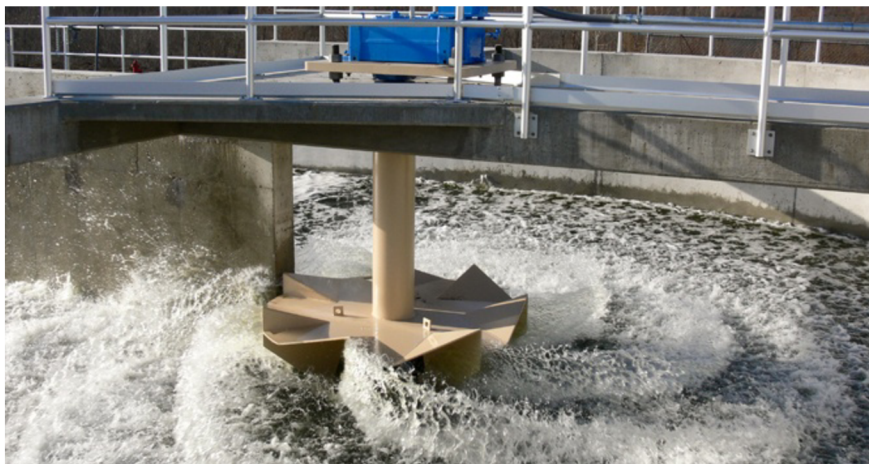
Obr. 5 Mechanický vertikální aerátor (URL 3)
