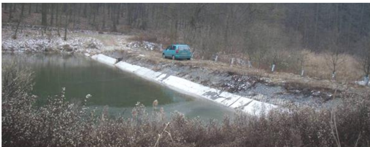
Obr. 5.10 Návodní líc po rekonstrukci (2007, Pařílková)
