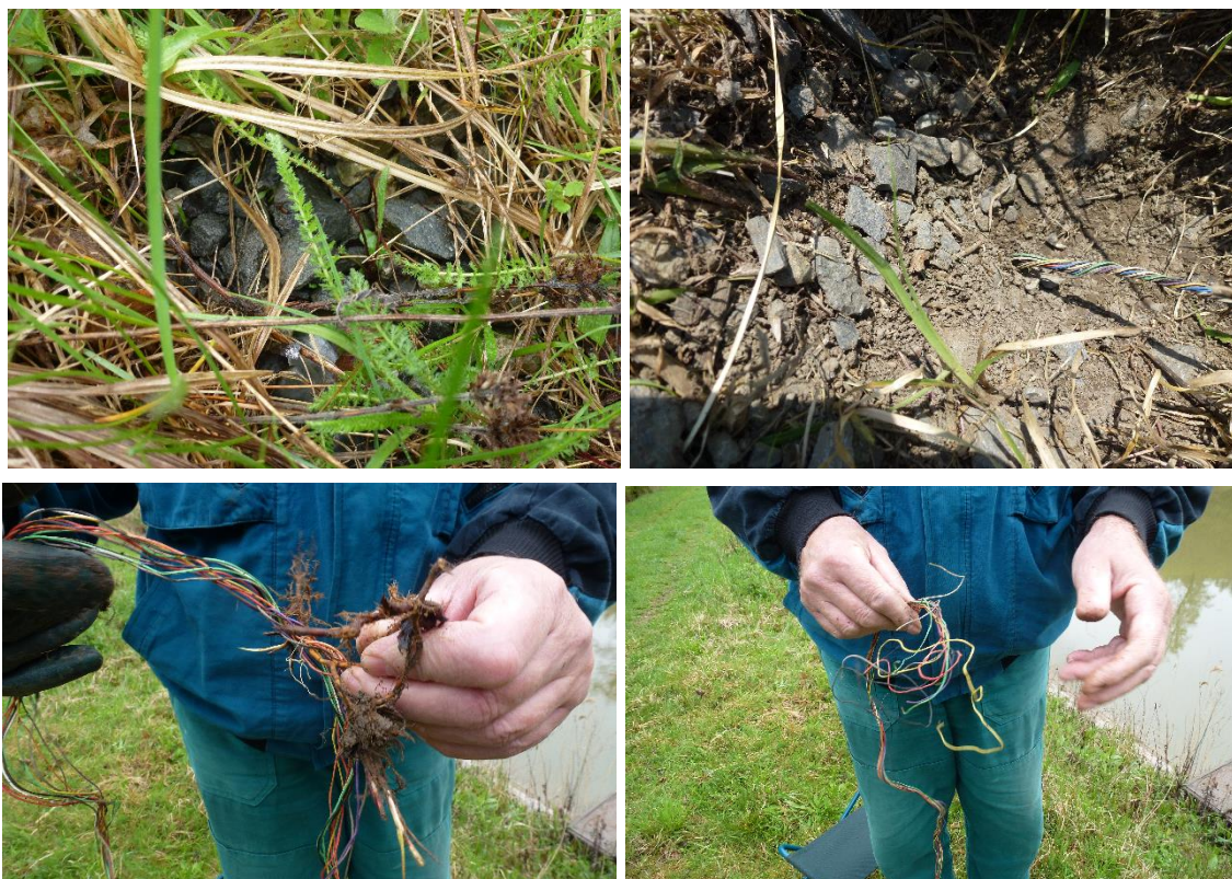
Obr. 4.12 Měřicí místa a stav obnažené kabeláže pro přenos signálů ze sond v roce 2016 – návodní líc, vpravo vzdušní líc (Koudelková)
