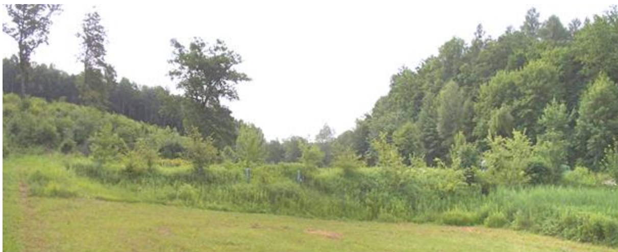
Obr. 5.9 Vzdušní líc hráze a vegetace pod hrází (2006, Pařílková)
