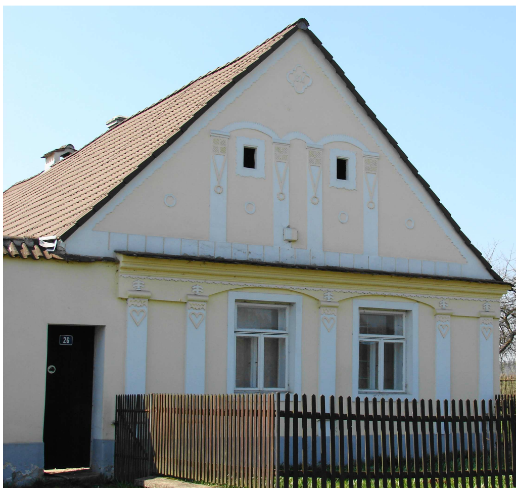
Obrázek 64: Svinky, průčelí selského stavení
