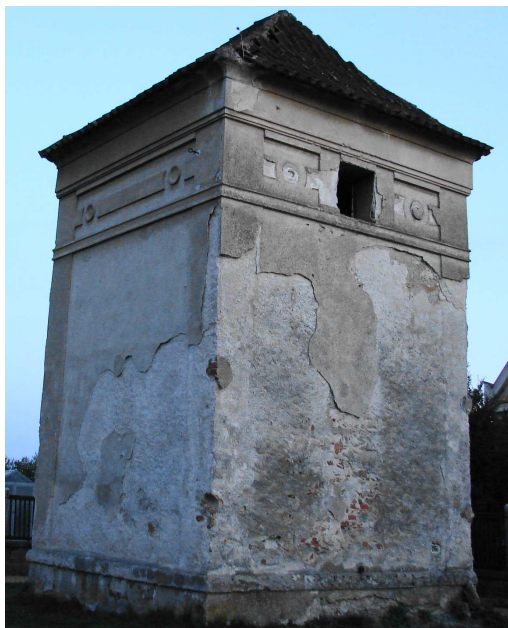
Obrázek 51: Štemberská vodárna dnes
