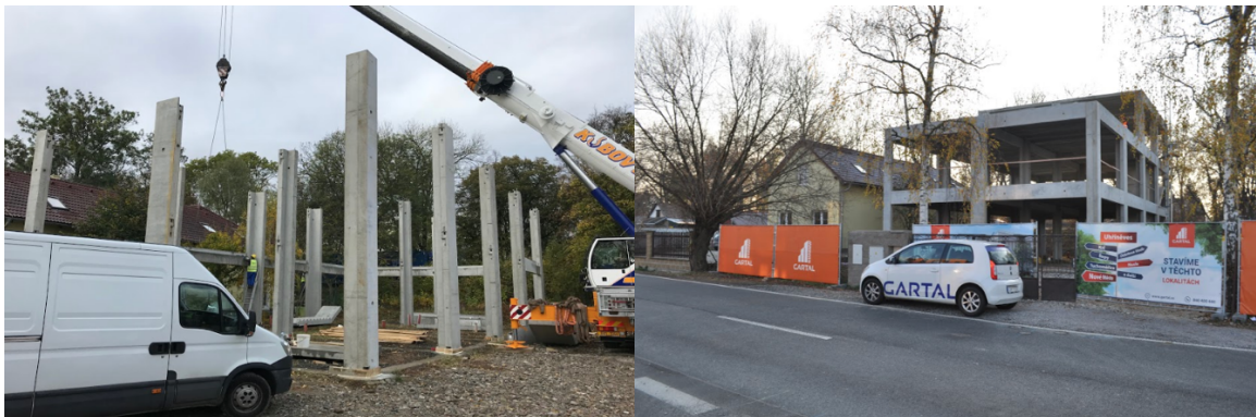
Období začátku výstavby v roce 2018
